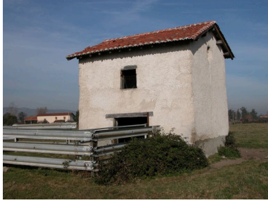
Vue générale Phot. Thierry Monnet IVR82_20134200263NUCA
