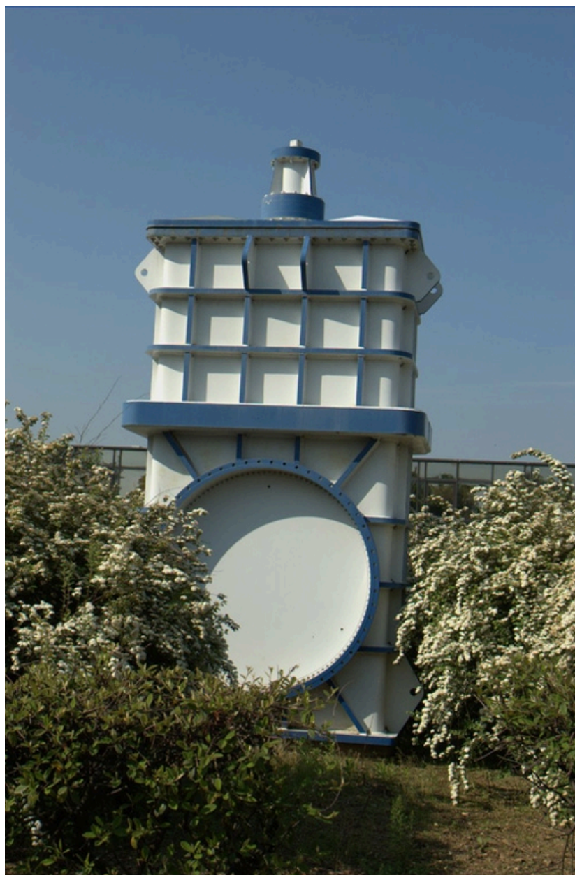
Cuve localisée dans le parc de l'entreprise
