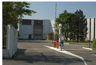
Entrée livraisons Phot. Nadine Halitim-Dubois IVR82_20086900428NUCA
