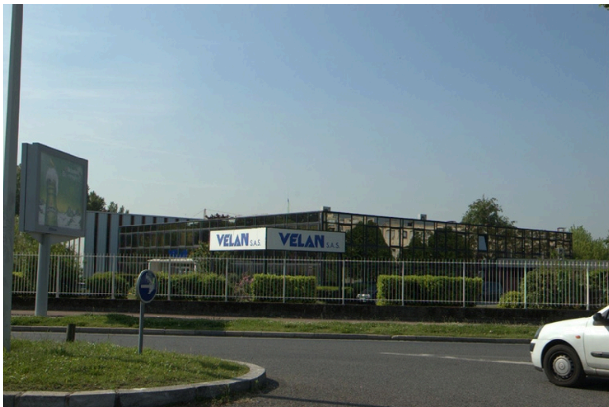
Vue générale nord avec enseigne VELAN
