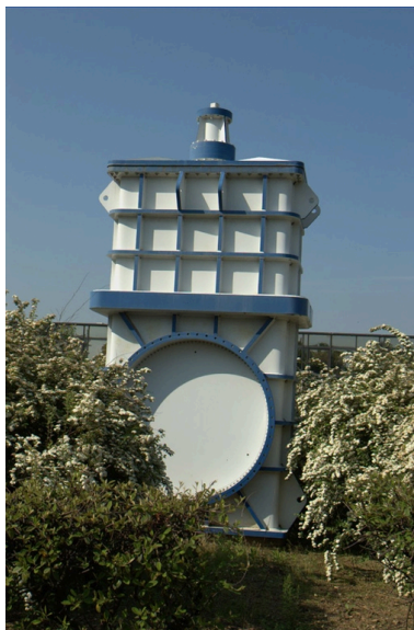
Cuve localisée dans le parc de l'entreprise Phot. Nadine Halitim-Dubois IVR82_20086900427NUCA
