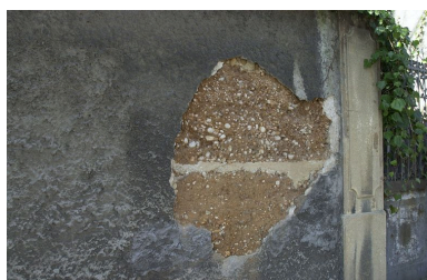
Détail du pisé de terre revêtu d'enduit du mur de clôture Phot. Véronique Belle IVR82_20036903180NUCA
