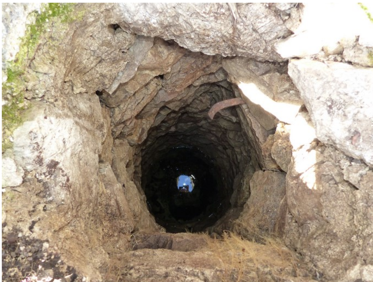
Vue de volume du cuvelage.
