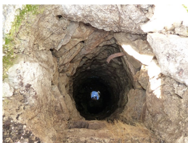
Vue de volume du cuvelage. Phot. Alexeï Laurent IVR84_20162600227NUCA
