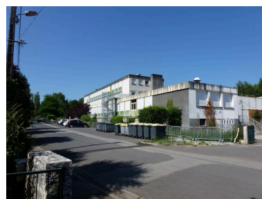
Vue générale depuis le fond de l'impasse Montaigne (depuis le nord-est). À droite du cliché, on aperçoit des éléments du chantier de construction de l'édifice de remplacement.
