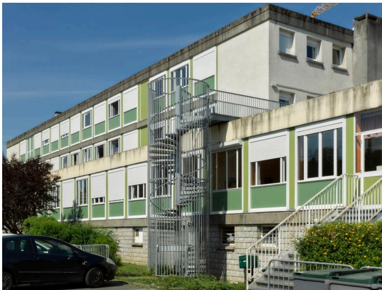
Façade principale depuis le nord-est : la volée à droite est l'escalier de secours de la cantine, l'escalier en vis est celui de l'internat.
