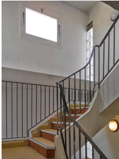
Escalier situé approximativement au centre de l'établissement. l'épaisseur des pavés de verre correspond à une saillie sur l'élévation arrière. Pour un second escalier, le même principe d'éclairage a été adopté.
