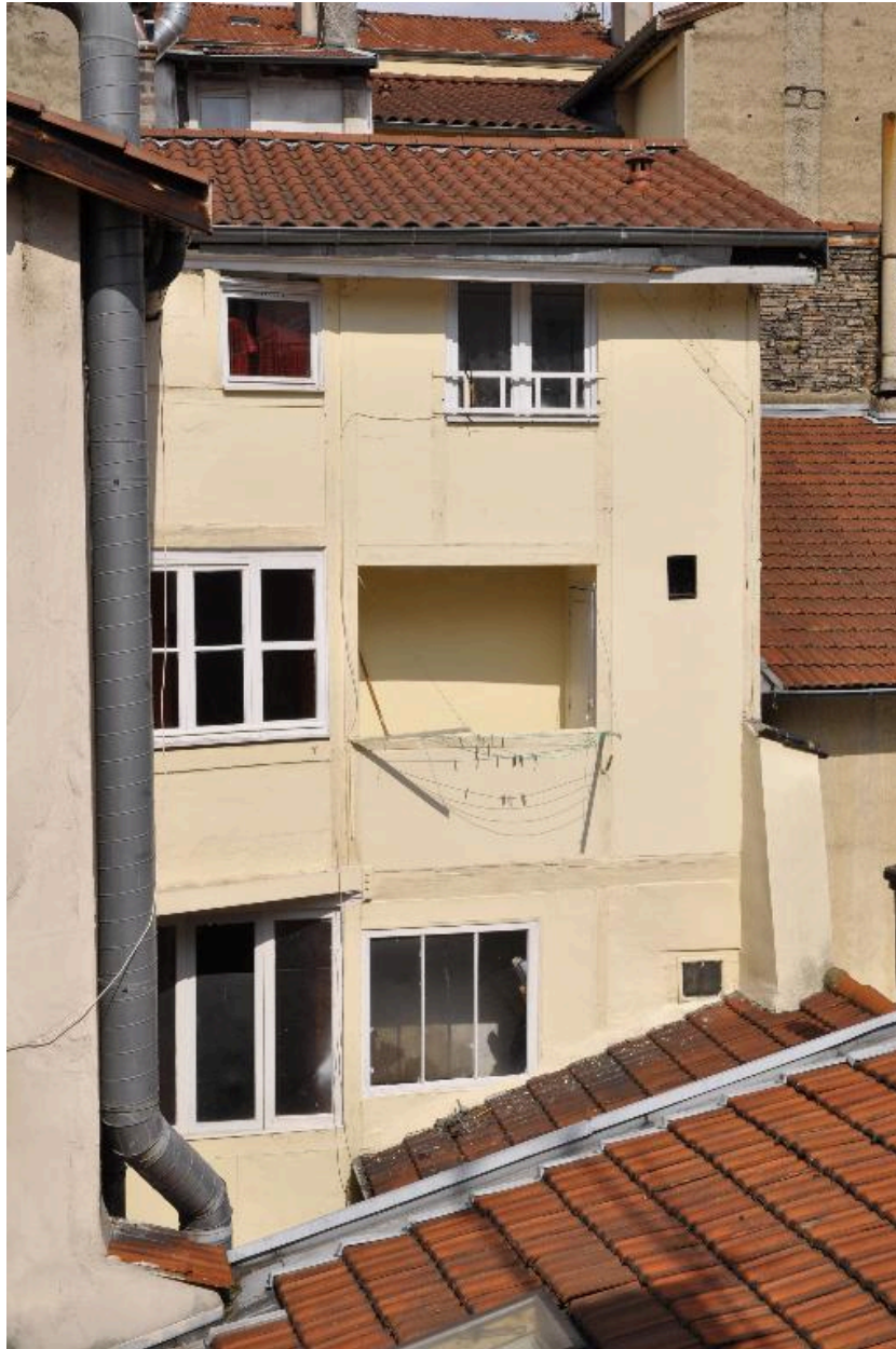
Elévations sur cour : corps de bâtiment en retour, structure en pan de bois
