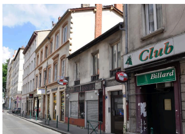
Vue générale depuis l'est : élévation sur rue et mur pignon Phot. Catherine Guégan IVR82_20156901046NUCA
