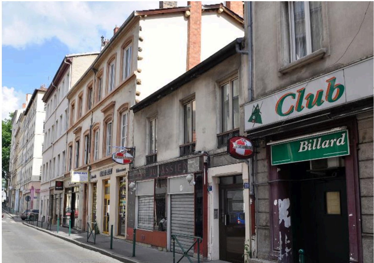
Vue générale depuis l'est : élévation sur rue et mur pignon
