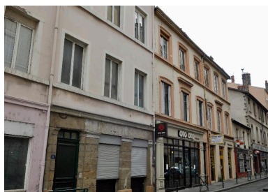
Vue de situation depuis l'ouest (à droite de l'image) Phot. Catherine Guégan IVR82_20156901040NUCA
