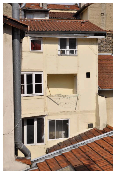
Elévations sur cour : corps de bâtiment en retour, structure en pan de bois Phot. Catherine Guégan IVR82_20156901071NUCA
