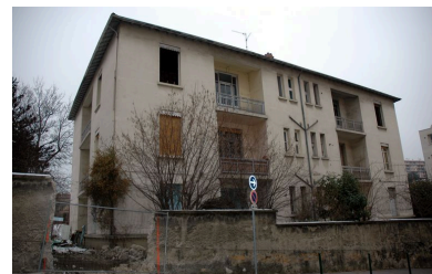
Elévation latérale rue Jean-Jullien Phot. Maryannick Chalabi IVR82_20066901003NUCA
