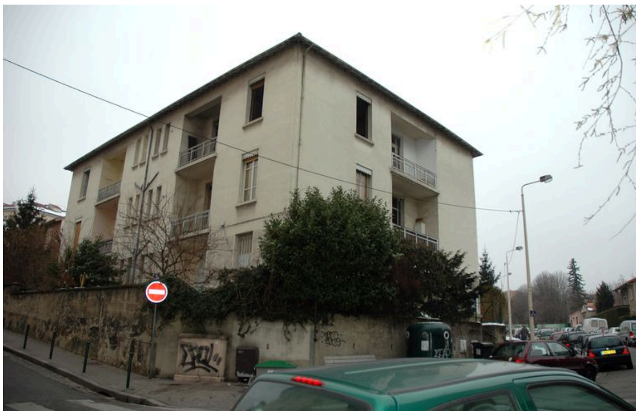
Vue depuis le nord-est, angle des rues Eugène-Pons et Jean-Jullien
