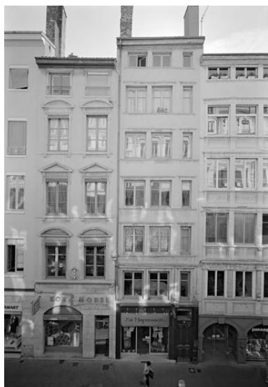
Façade, vue générale Phot. Eric Dessert IVR82_20056901729P
