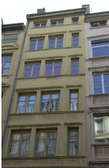
Façade, niveaux 3 à 7 Phot. Maryannick Chalabi IVR82_20036901108NUCA
