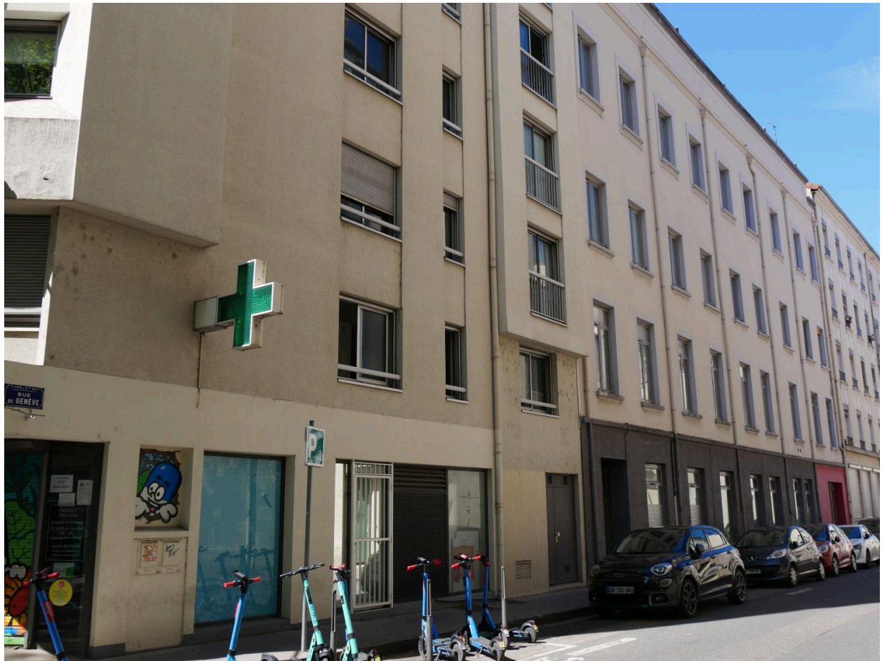
Vue de l'usine à étage
