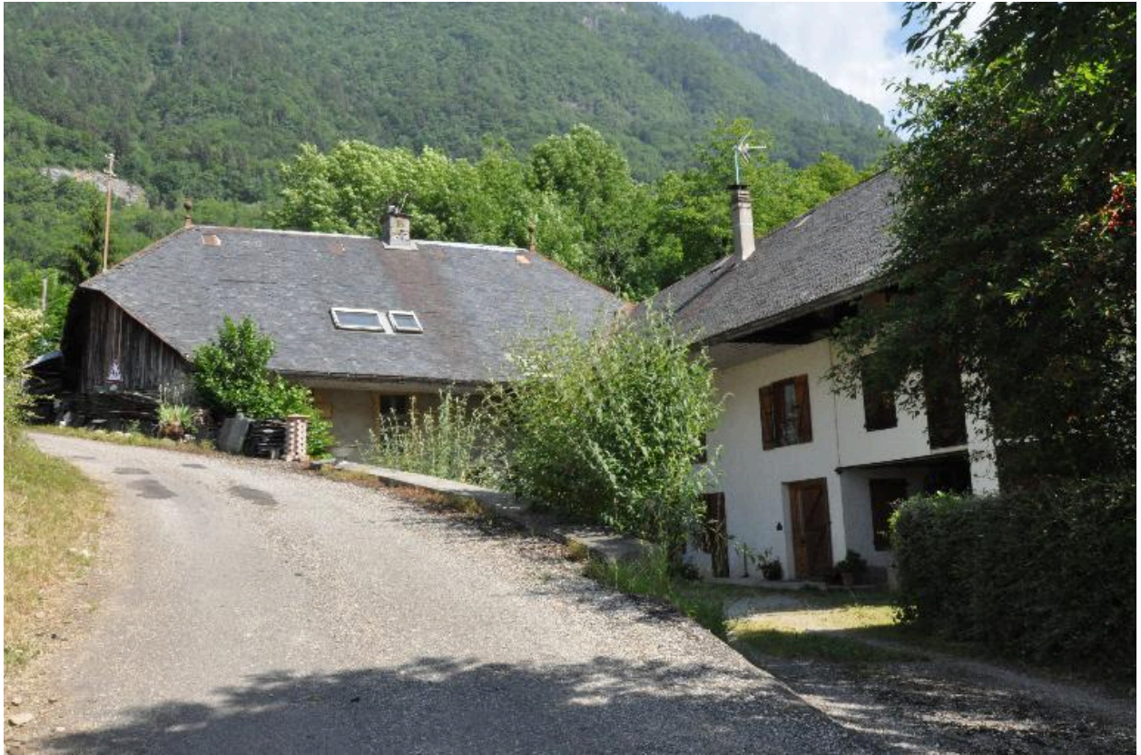
Vue de l'ancienne forge.
