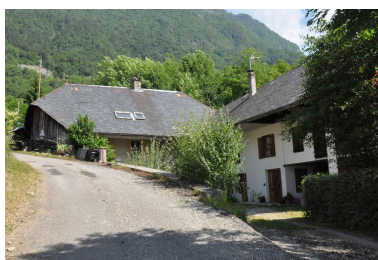
Vue de l'ancienne forge. Phot. Clara Bérelle IVR82_20147303908NUCA
