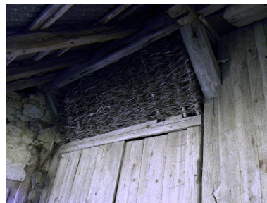
Détail de clayonnage pour aérer le fénil sous le toit. Phot. Jérôme Daviet IVR84_20167400753NUCA
