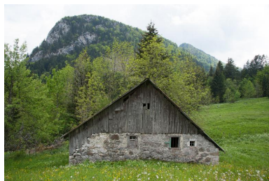
Vue du pignon nord. Phot. Emmanuel Breteau IVR82_20137400799NUCA
