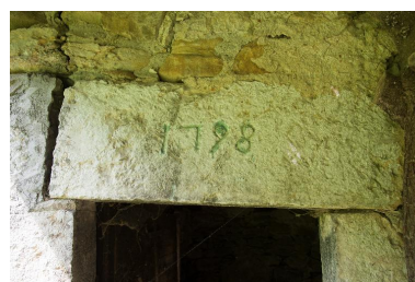
Détail du linteau de la porte du logis daté 1798. Phot. Emmanuel Breteau IVR82_20137400800NUCA
