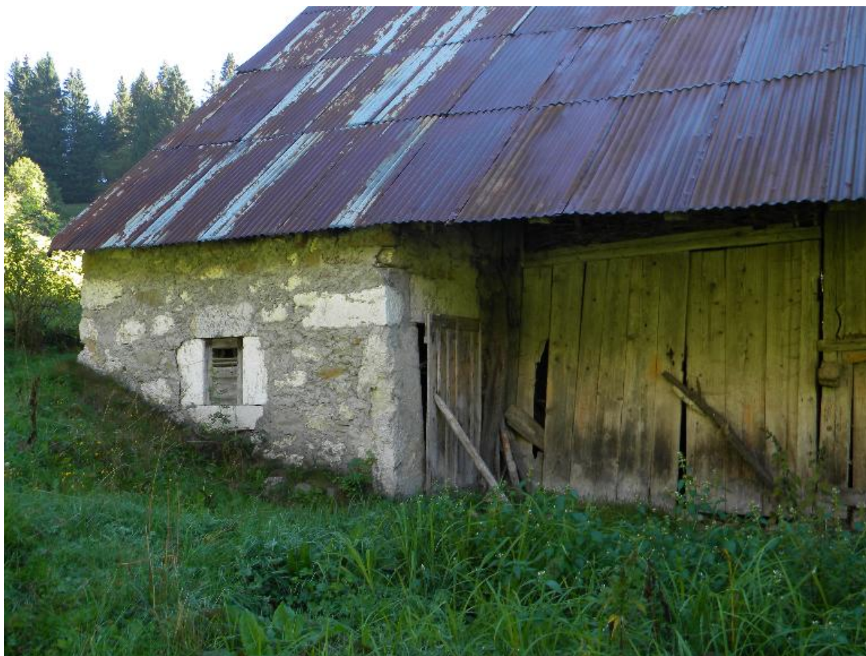
Vue de la partie logis en maçonnerie.
