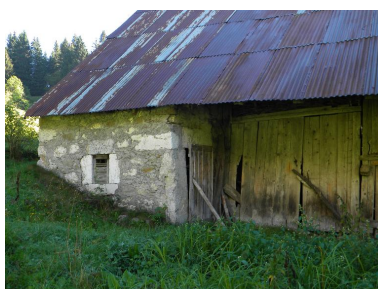
Vue de la partie logis en maçonnerie. Phot. Jérôme Daviet IVR84_20167400751NUCA
