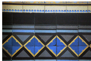
Carrelage du vestibule. Détail Phot. Maryannick Chalabi IVR82_20076900445NUCA
