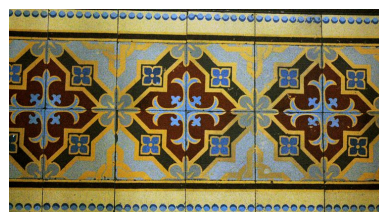
Carrelage du vestibule. Détail Phot. Maryannick Chalabi IVR82_20076900443NUCA
