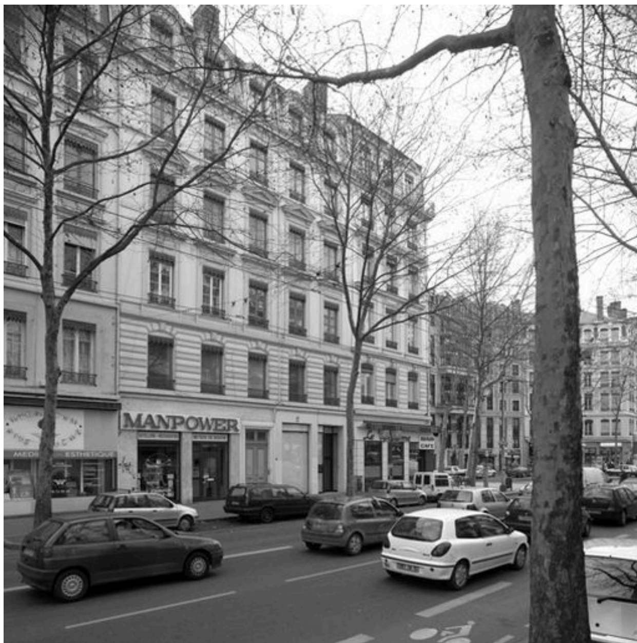
Elévation principale depuis le nord-est
