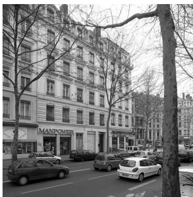
Elévation principale depuis le nord-est Phot. Eric Dessert IVR82_20056900603NUC
