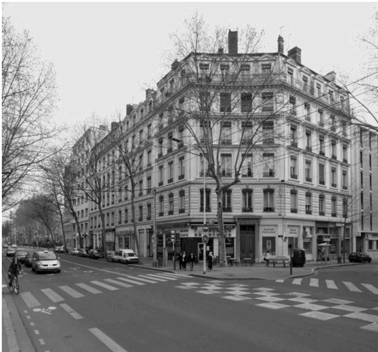
Vue générale depuis le nord-ouest
