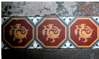
Carrelage du vestibule. Détail Phot. Maryannick Chalabi IVR82_20076900444NUCA
