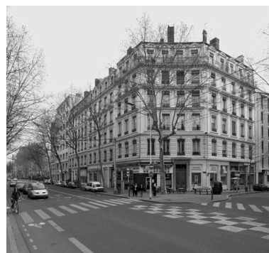
Vue générale depuis le nord-ouest Phot. Eric Dessert IVR82_20056900601NUC
