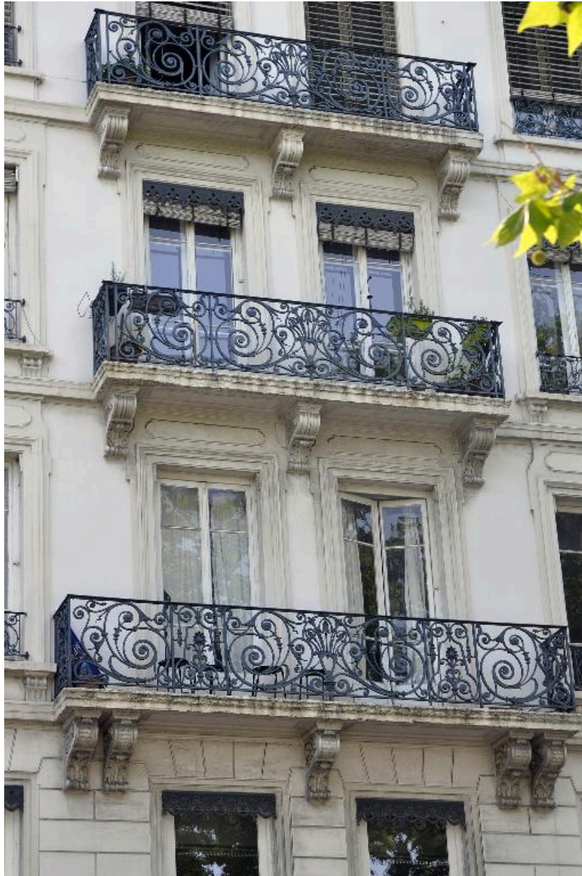
Vue rapprochée de l'élévation sur quai : les balcons superposés
