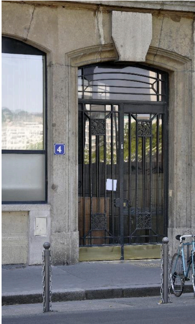
Vue rapprochée de l'élévation sur quai : entrée piétonne
