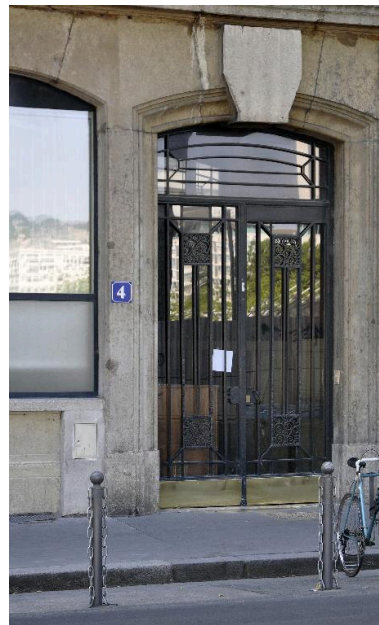
Vue rapprochée de l'élévation sur quai : entrée piétonne Phot. Magali Delavenne IVR82_20146902706NUCA
