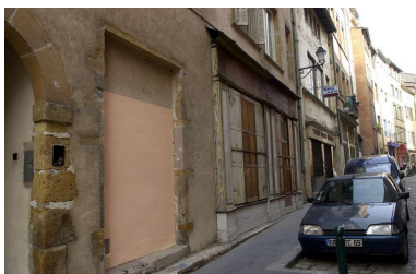
Vue générale du rez-de-chaussée Phot. Véronique Belle IVR82_20036902531NUCA
