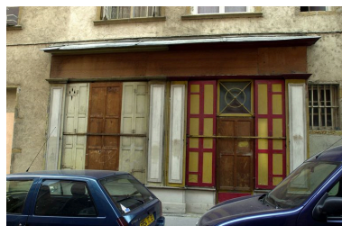
Devanture de la boutique Phot. Véronique Belle IVR82_20036902532NUCA
