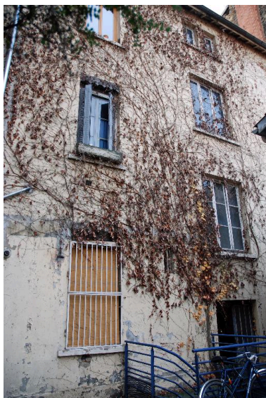
Vue partielle de l'élévation sur cour Phot. Magali Delavenne IVR82_20146902982NUCA
