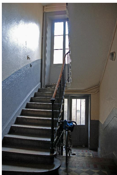
Vue du départ de l'escalier Phot. Magali Delavenne IVR82_20146902984NUCA
