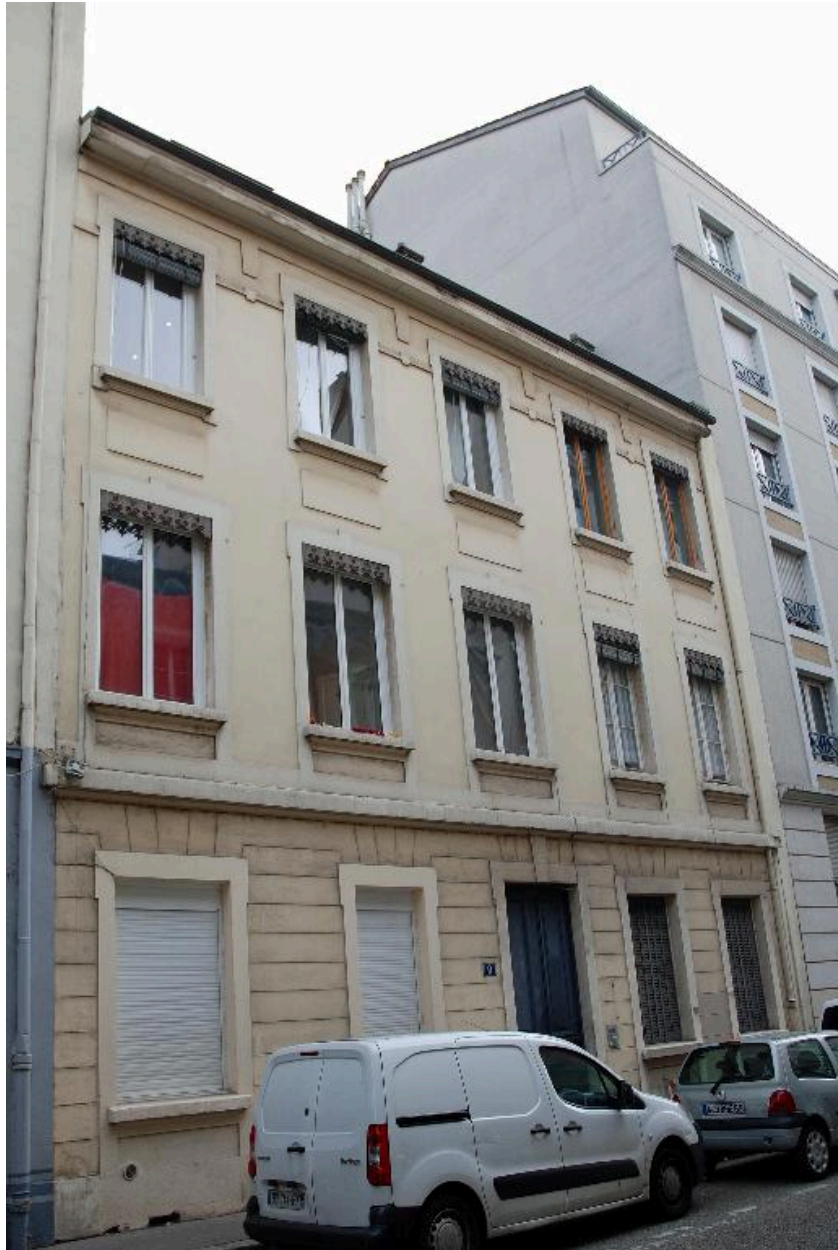
Vue générale de l'élévation sur rue
