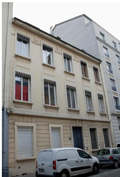
Vue générale de l'élévation sur rue Phot. Magali Delavenne IVR82_20146902981NUCA
