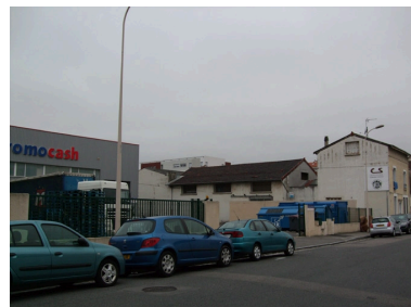
Vue d'ensemble nord-est Phot. Nadine Halitim-Dubois IVR82_20086901903NUCA
