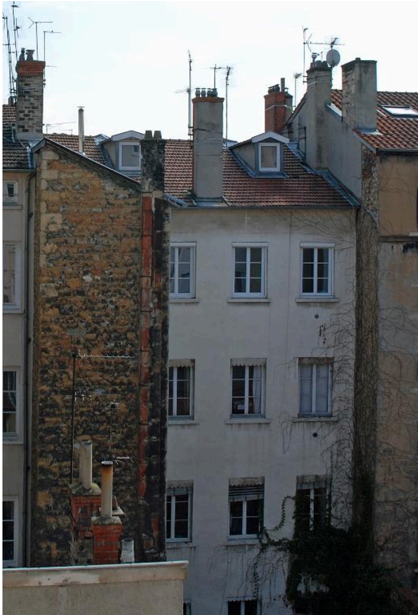
Vue générale de l'élévation sur cour
