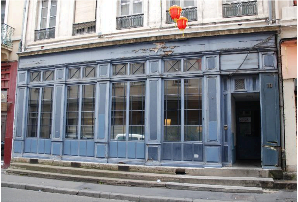
Vue rapprochée du rez-de-chaussée avec devanture ancienne
