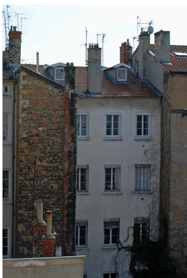
Vue générale de l'élévation sur cour Phot. Catherine Guégan IVR82_20156900983NUCA
