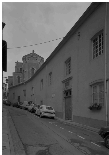
Elévation sur rue. Phot. Eric Dessert IVR82_19910100064P
