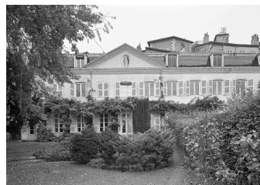
Elévation sur jardin. Phot. Eric Dessert IVR82_19900100393P
