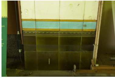
Partie inférieure du mur traitée en soubassement par l'utilisation d'une frise en carreaux de céramique, mur est Phot. Véronique Belle IVR82_20046901599NUCA
