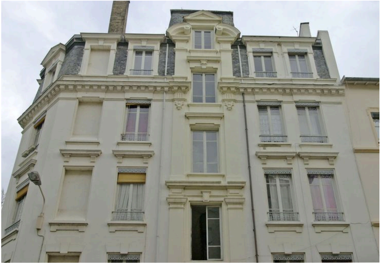
Partie supérieure de l'élévation sur la rue Béguin
