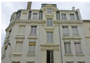
Partie supérieure de l'élévation sur la rue Béguin Phot. Maryannick Chalabi IVR82_20066901352NUCA
