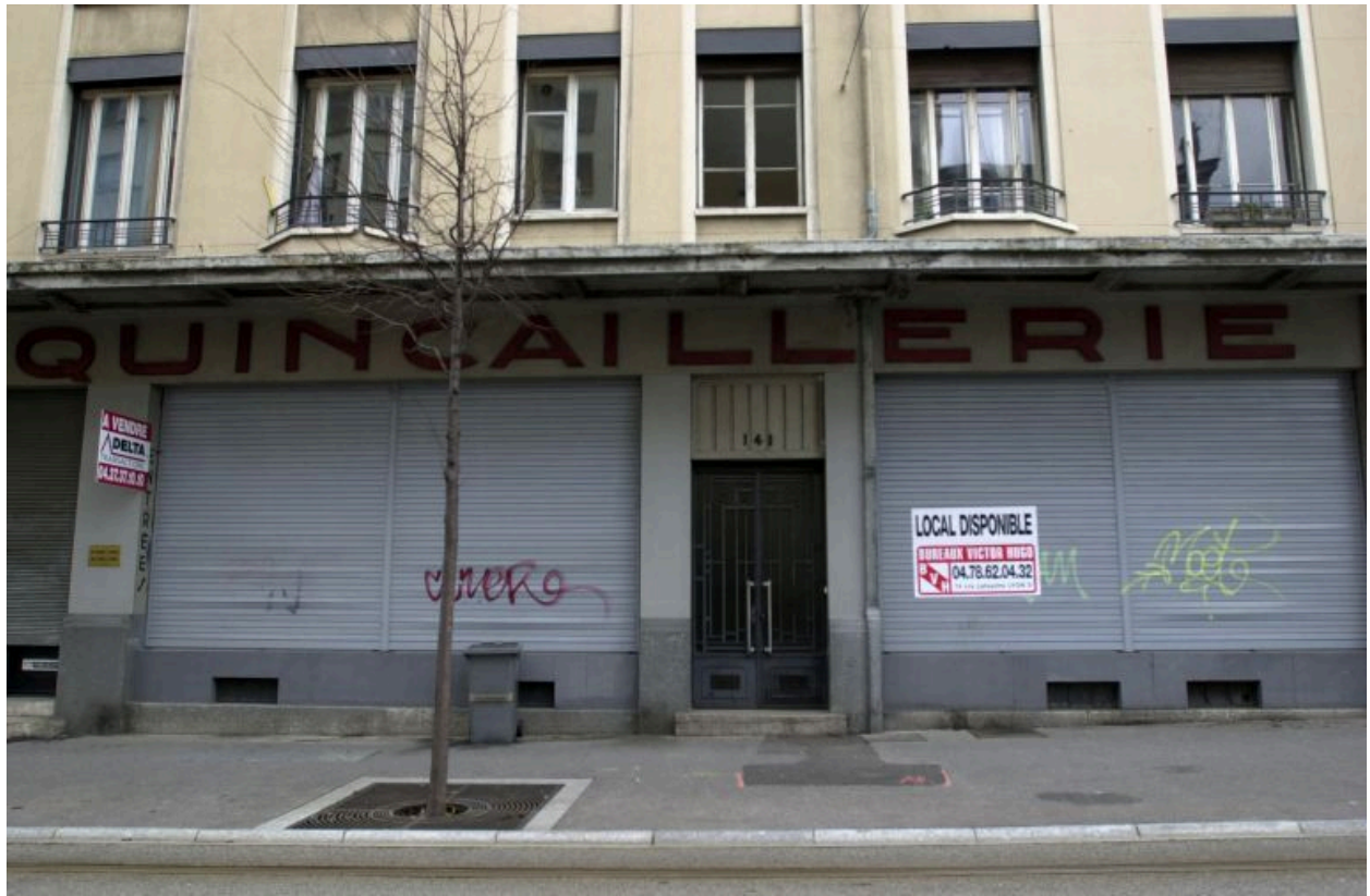
Vue du rez-de-chaussée
