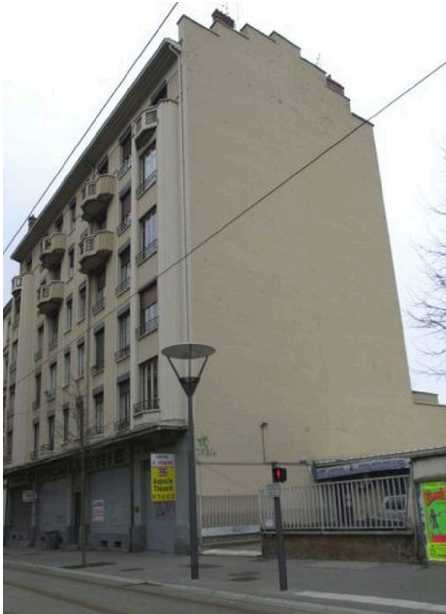
Vue du mur pignon est depuis le sud-est
