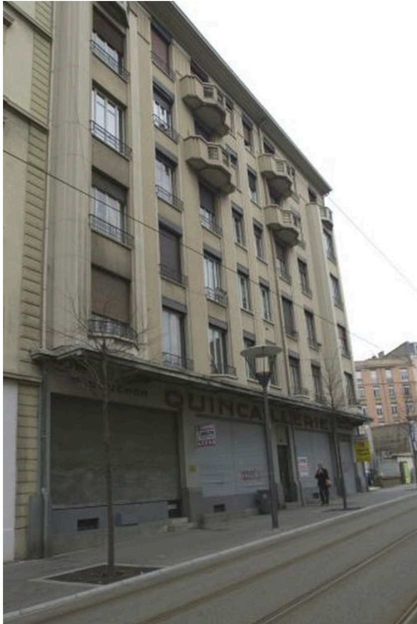
Vue de l'élévation depuis le nord-ouest
