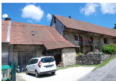
Grange-étable (2017 D2 135), non repérée. Phot. Thierry Monnet IVR84_20207400656NUCA
