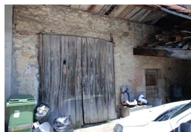
Grange-étable (2017 D2 135), non repérée. Phot. Thierry Monnet IVR84_20207400655NUCA
