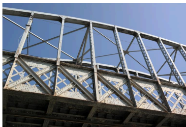
Pont ferroviaire de Vongy, détail de la structure métallique Phot. Pascale Renard IVR84_20207401543NUCA
