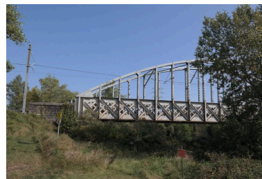
Pont ferroviaire de Vongy, détail rive gauche Phot. Pascale Renard IVR84_20207401544NUCA
