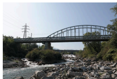
Pont ferroviaire de Vongy, vue de la face aval Phot. Pascale Renard IVR84_20207401538NUCA
