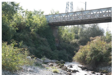
Pont ferroviaire de Vongy, culée rive droite Phot. Pascale Renard IVR84_20207401542NUCA
