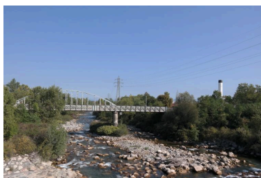
Pont ferroviaire de Vongy, vue de la face amont Phot. Pascale Renard IVR84_20197401228NUCA
