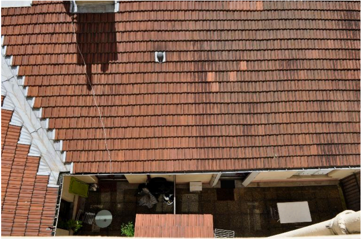
Vue partielle de la cour et de la toiture des bâtiments sur cour
