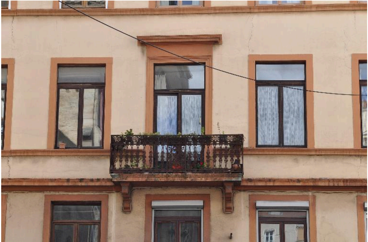
Elévation sur rue, détail du balcon au deuxième étage
