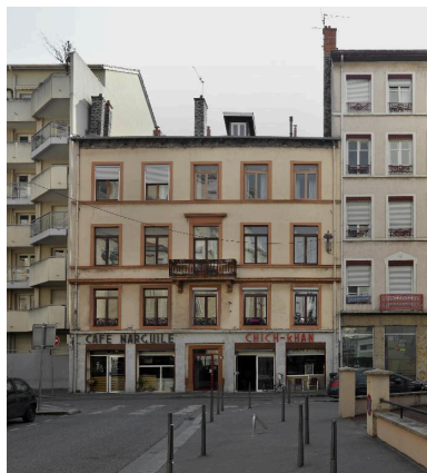
Vue générale, élévation sur rue Phot. Eric Dessert IVR84_20176900460NUCAQ
