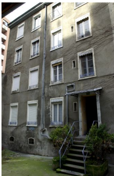
L'élévation principale et son perron Phot. Maryannick Chalabi IVR82_20016900256NUCA
