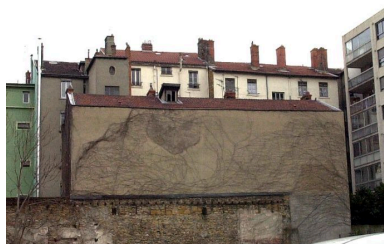
Elévation postérieure Phot. Maryannick Chalabi IVR82_20016900285NUCA
