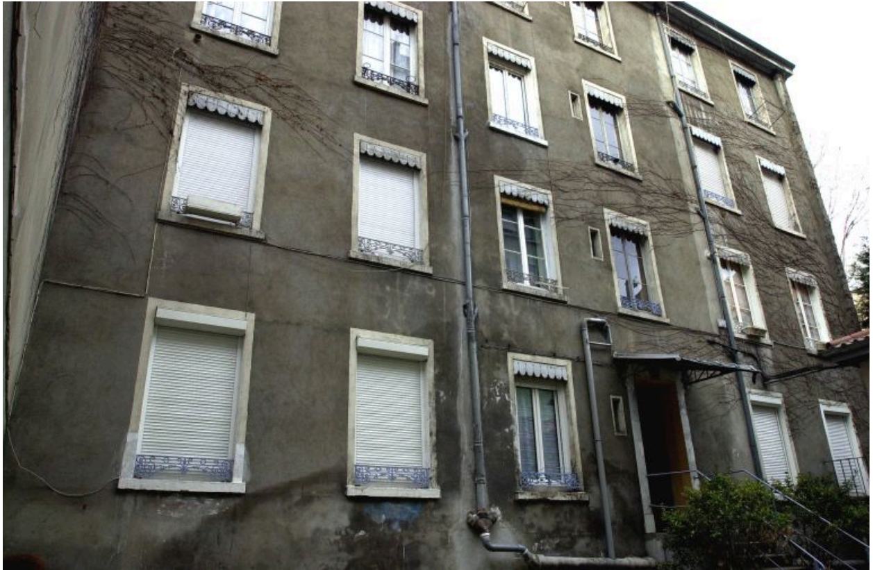
Elévation principale depuis le sud-est.
