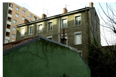
Vue de l'immeuble depuis le nord-est (cour du 12 cours Charlemagne) Phot. Maryannick Chalabi IVR82_20016900254NUCA
