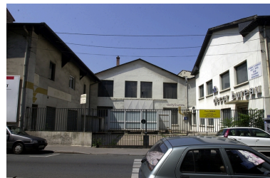
Façade est Phot. Nadine Halitim-Dubois IVR82_20036901644NUCA
