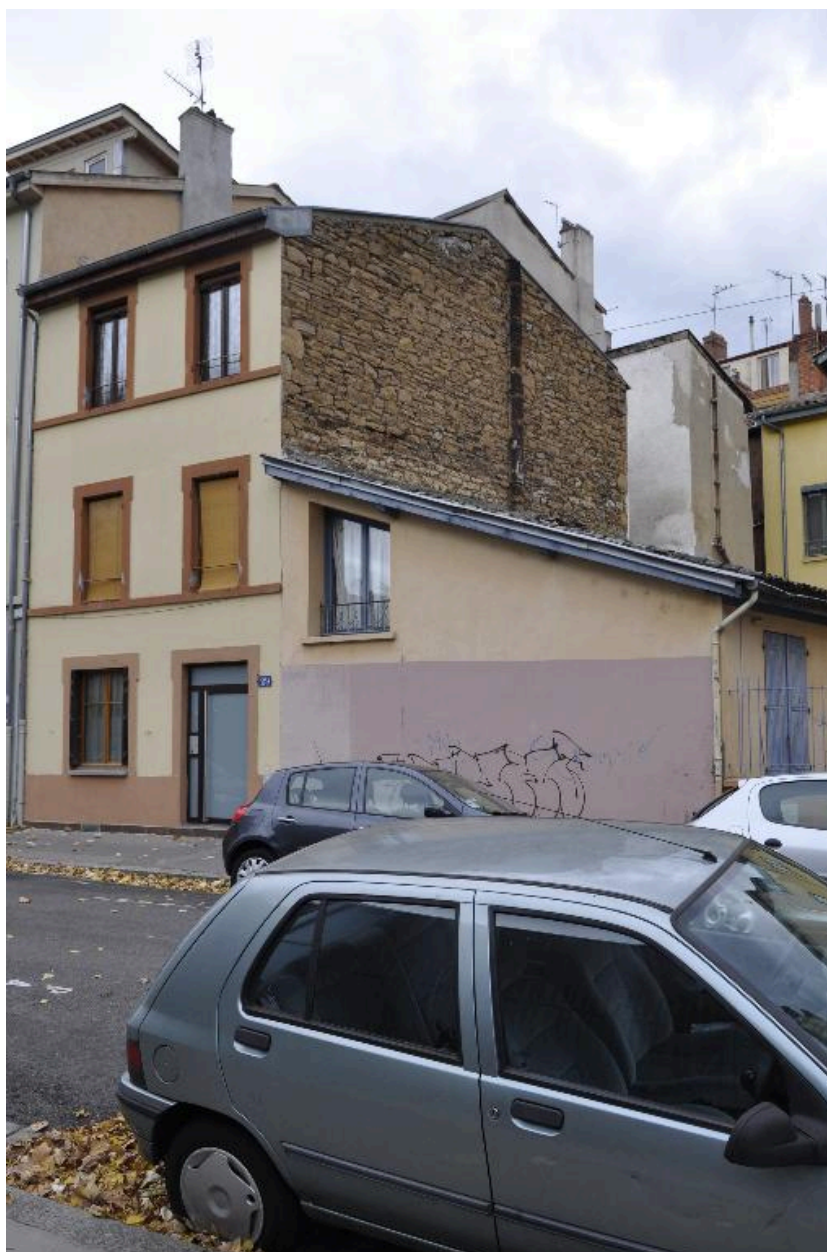
Vue latérale, moellons apparents sur le mur pignon
