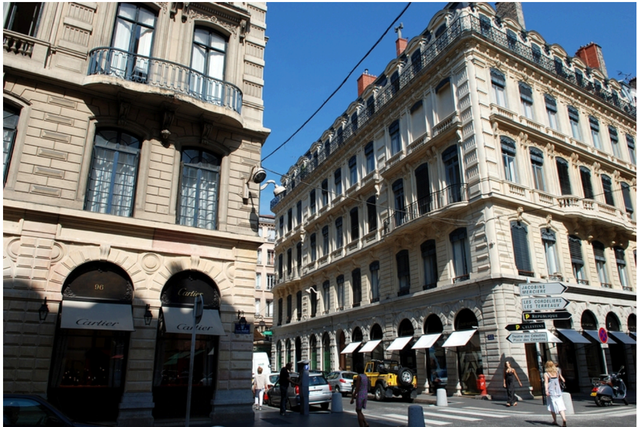
Vue d'ensemble. Au premier plan, l'immeuble 10 rue des Archers portant la signature de Casimir Echernier
