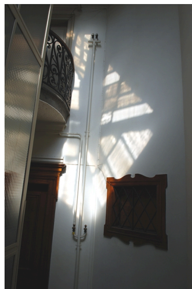
Escalier ouest : garde-corps et fenêtre de second jour Phot. Véronique Belle IVR82_20096904744NUCA
