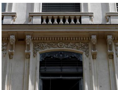
Fenêtres du 2e étage carré : pampres Phot. Eric Dessert IVR82_20126901509NUCA
