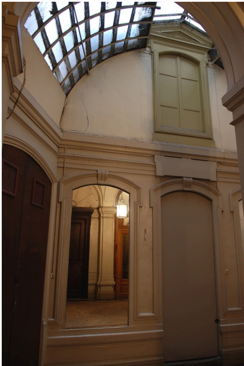
Le vestibule : vue partielle avec la verrière et la loge de concierge
