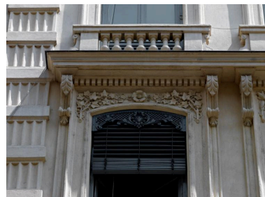
Fenêtres du 2e étage carré : branches de lierre Phot. Eric Dessert IVR82_20126901507NUCA
