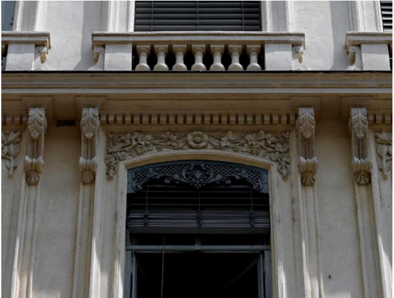
Fenêtres du 2e étage carré : pampres
