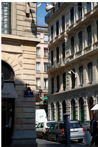
Elévation rue des Archers. Au premier plan, la signature de l'architecte Echernier sur l'immeuble sis 10 rue des Archers Phot. Véronique Belle IVR82_20096904738NUCA
