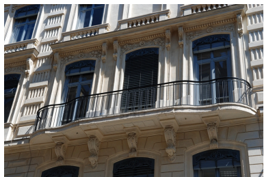
Détail du balcon Phot. Véronique Belle IVR82_20096904650NUCA
