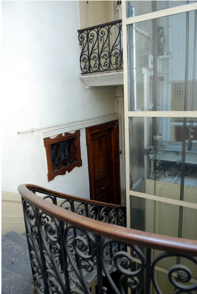
Escalier est : porte palière, fenêtre de second jour et garde-corps
