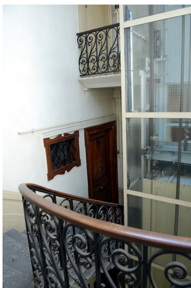
Escalier est : porte palière, fenêtre de second jour et garde-corps Phot. Véronique Belle IVR82_20096904746NUCA
