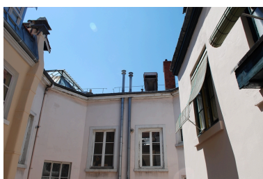
Elévation sur cour : dernier étage Phot. Véronique Belle IVR82_20096904663NUCA
