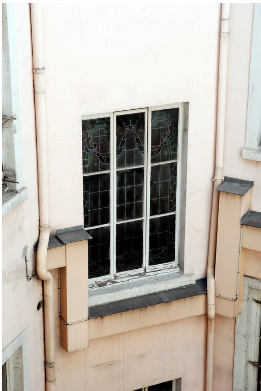
Elévation sur cour : détail d'une fenêtre fermée d'un vitrail
