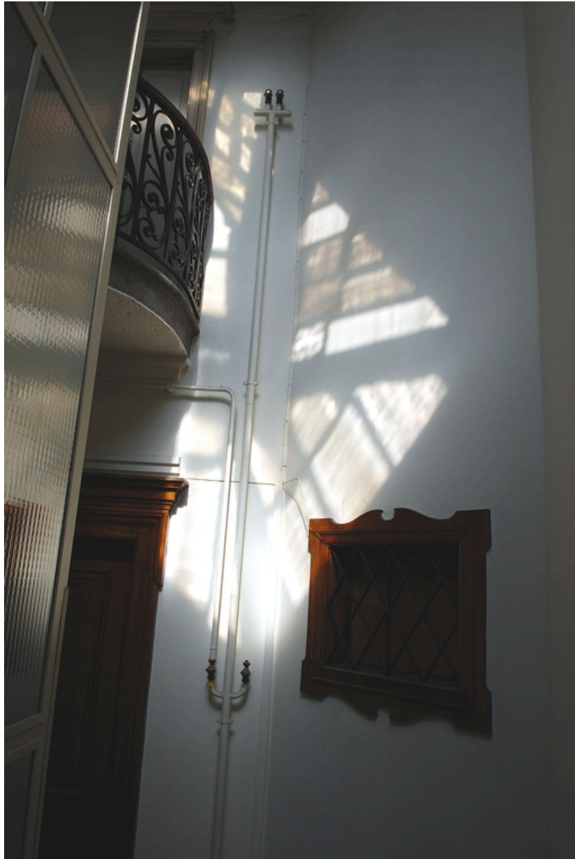
Escalier ouest : garde-corps et fenêtre de second jour
