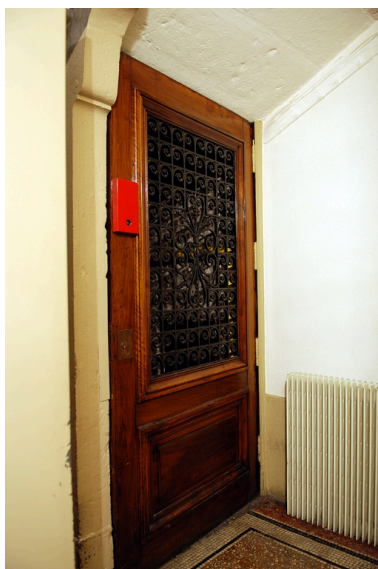
Escalier ouest : porte de cave Phot. Véronique Belle IVR82_20096904743NUCA
