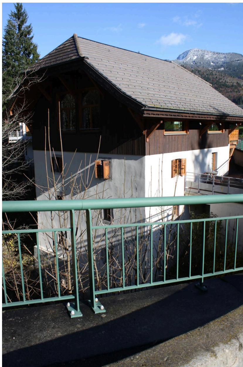
Pont de Molliet, gardes corps et le moulin de Seytroux
