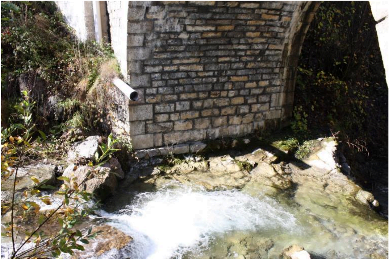
Pont de Molliet, détail intrados
