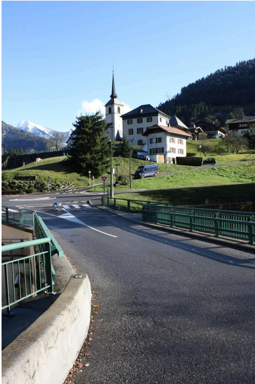
Pont de Molliet, contexte et chaussée
