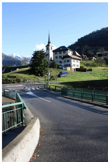
Pont de Molliet, contexte et chaussée Phot. Benoît Huraut IVR84_20207401276NUCA
