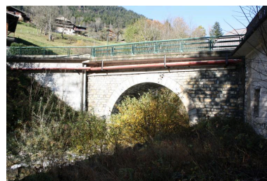
Pont de Molliet, face amont IVR84_20197401284NUCA
