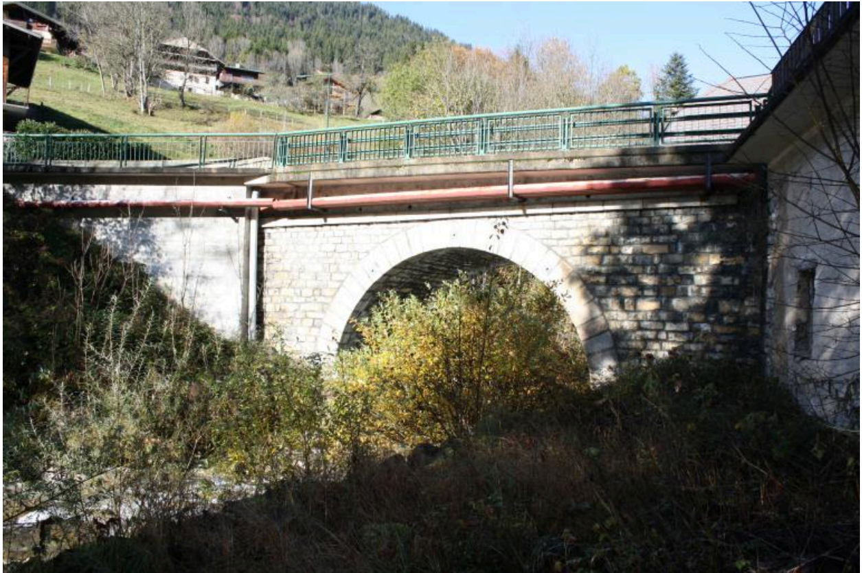
Pont de Molliet, face amont
