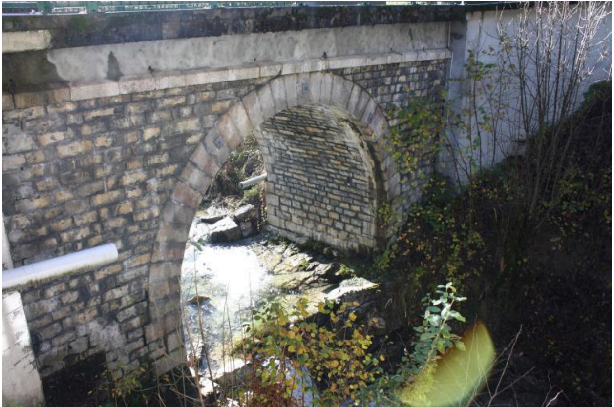
Pont de Molliet, détail voute
