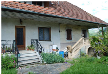
Détail est de la façade principale. Phot. Thierry Monnet IVR84_20187400361NUCA
