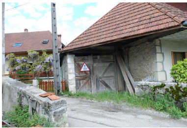
Détail ouest de la façade principale. Phot. Thierry Monnet IVR84_20187400360NUCA
