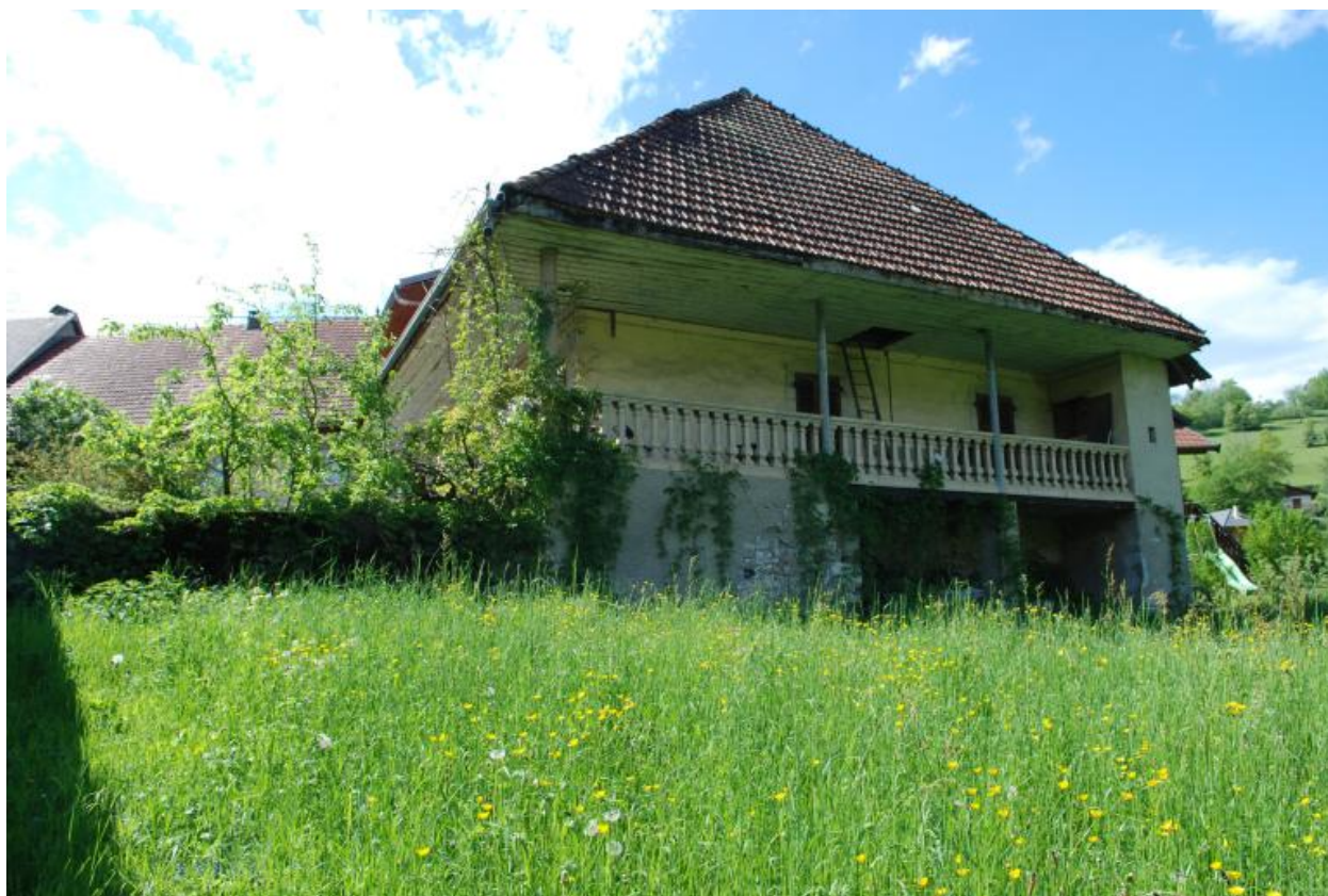
Vue d'ensemble du pignon est de la ferme.
