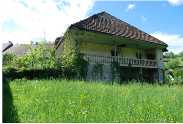
Vue d'ensemble du pignon est de la ferme. Phot. Thierry Monnet IVR84_20187400358NUCA
