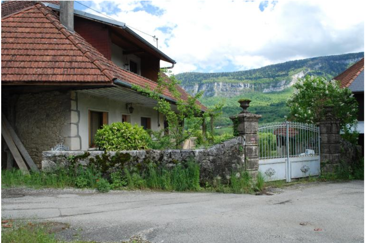
Vue d'ensemble de trois-quarts avant gauche.
