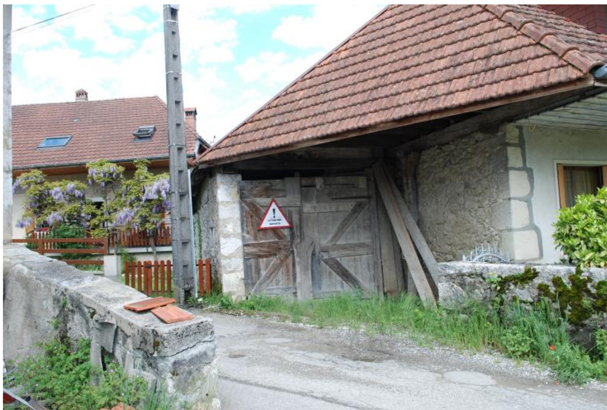
Détail ouest de la façade principale.
