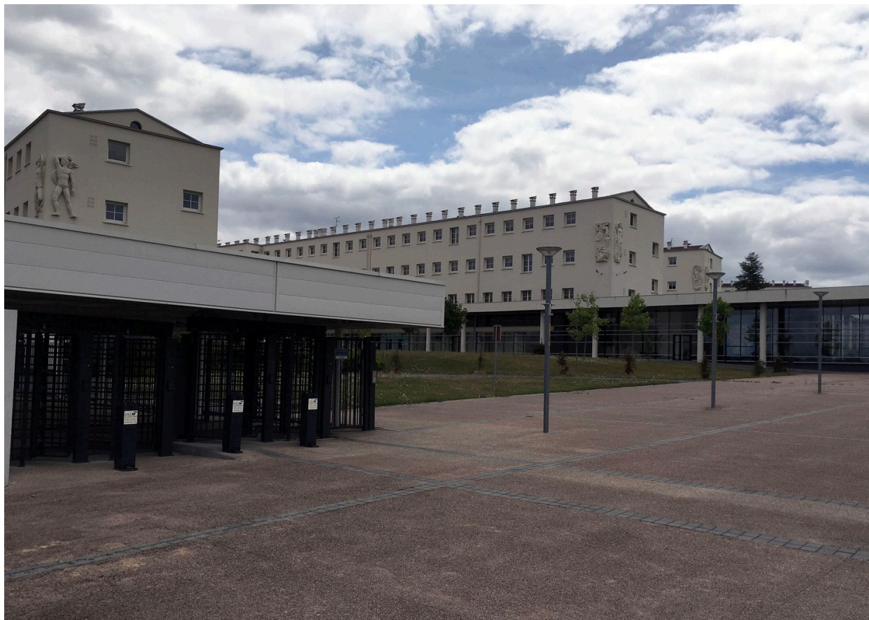
Vue d'ensemble des bas-reliefs de Belmondo et Poisson sur les élévations des bâtiments d'enseignement et de l'internat, depuis l'esplanade du lycée
