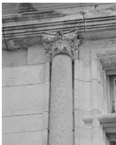
Cour du puits. Façade est. Troisième niveau. La deuxième colonne et son chapiteau.
