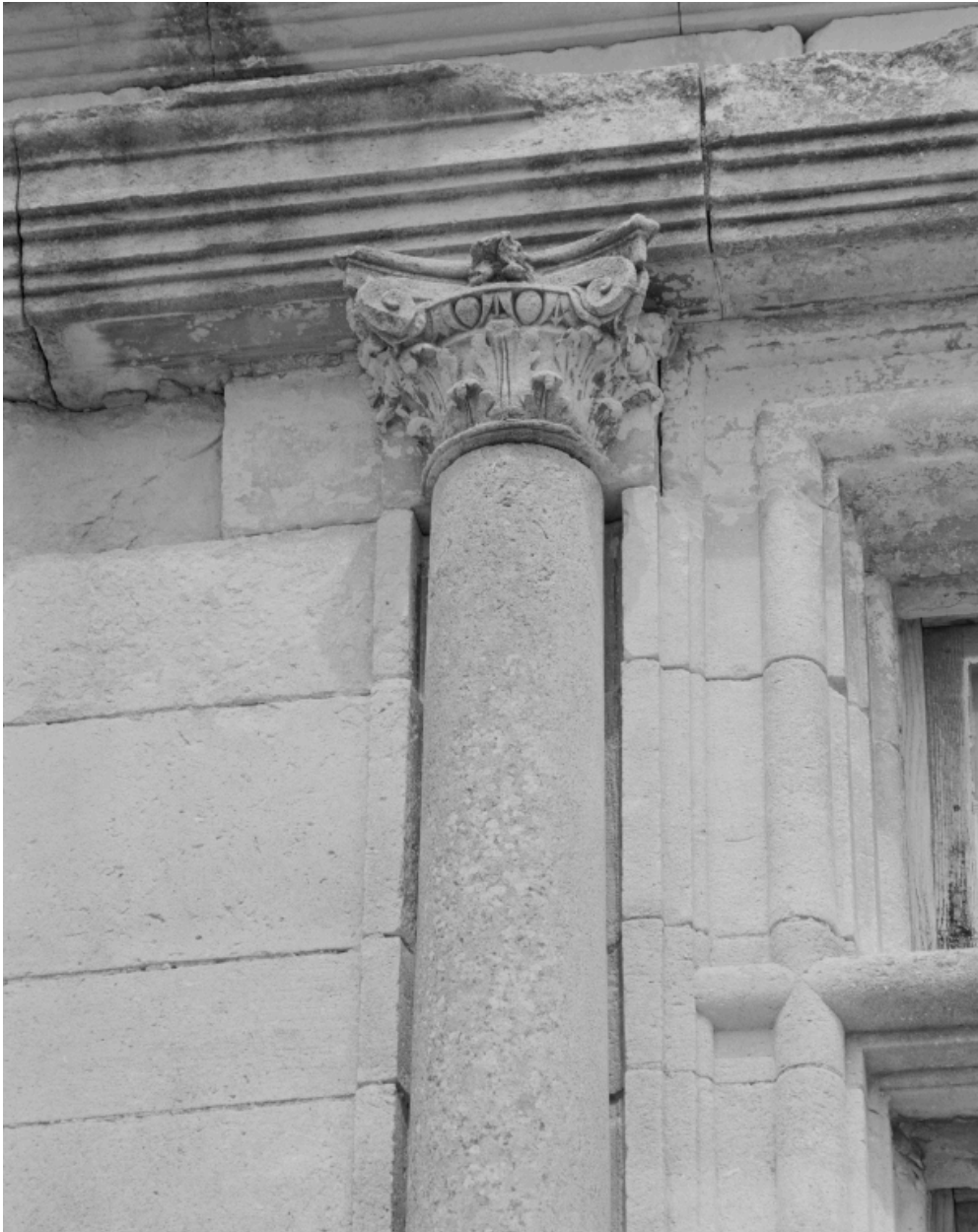
Cour du puits. Façade est. Troisième niveau. La deuxième colonne et son chapiteau.
