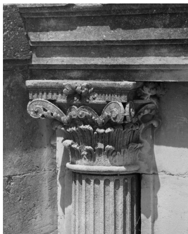
Cour du puits. Façade est. Deuxième niveau. Détail du premier chapiteau.
