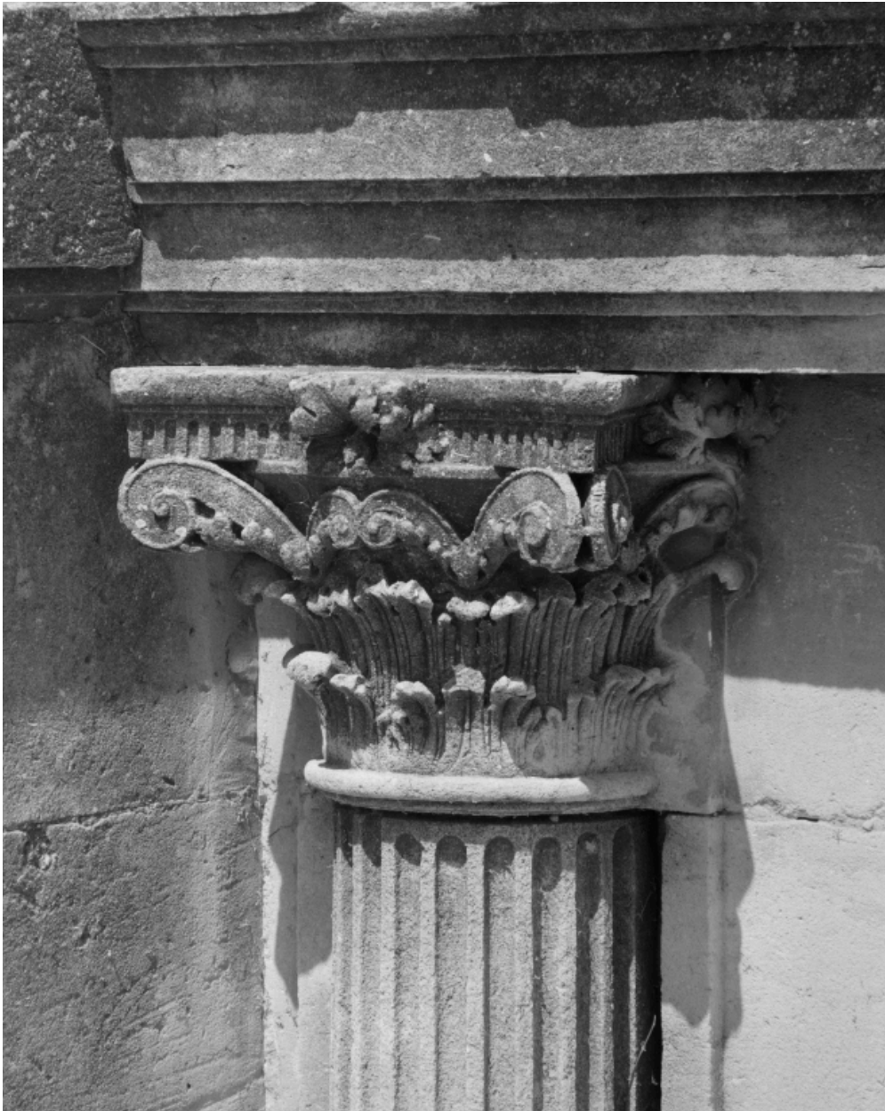
Cour du puits. Façade est. Deuxième niveau. Détail du premier chapiteau.
