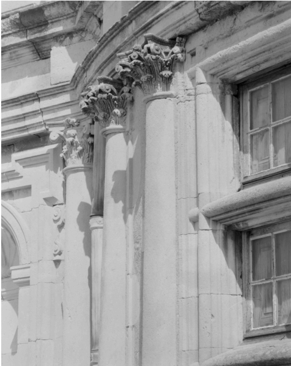
Bâtiment sud. Tour sud-est. Ordre du deuxième niveau. Vue rapprochée.
