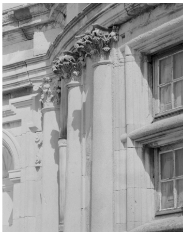
Bâtiment sud. Tour sud-est. Ordre du deuxième niveau. Vue rapprochée. Phot. Alain Franchella IVR82_19982600725X
