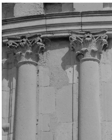
Bâtiment sud. Façade sur la basse-cour. Niche et ordre du troisième niveau. Phot. Alain Franchella IVR82_19982600723X
