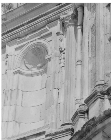
Bâtiment sud. Façade sur la basse-cour. Niche et ordre du troisième niveau. Phot. Alain Franchella IVR82_19982600730X
