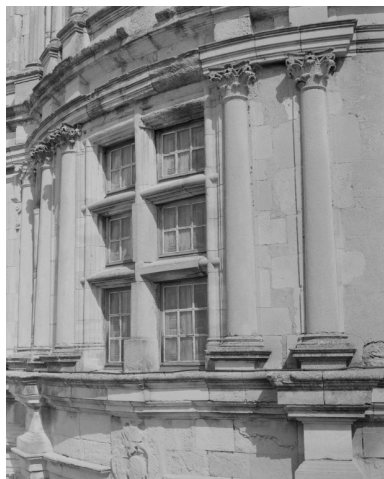
Bâtiment sud. Tour sud-est. Ordres du deuxième niveau. Phot. Alain Franchella IVR82_19982600726X
