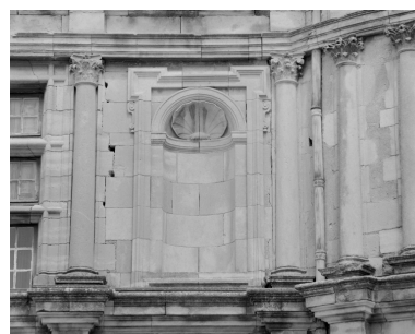
Bâtiment sud. Façade sur la basse-cour. Niche et ordre du deuxième niveau. Phot. Alain Franchella IVR82_19982600753X
