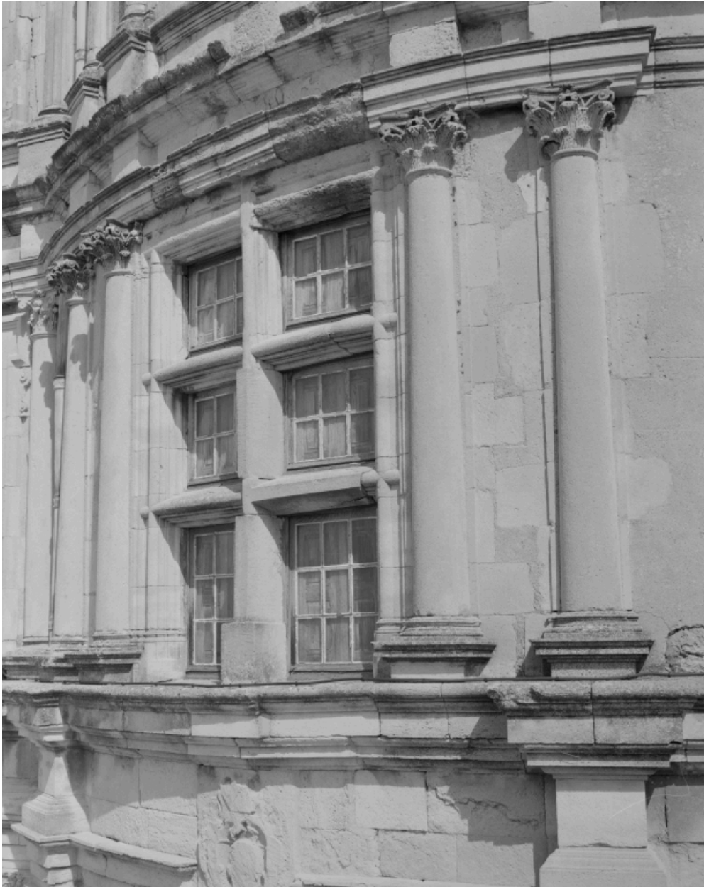
Bâtiment sud. Tour sud-est. Ordres du deuxième niveau.
