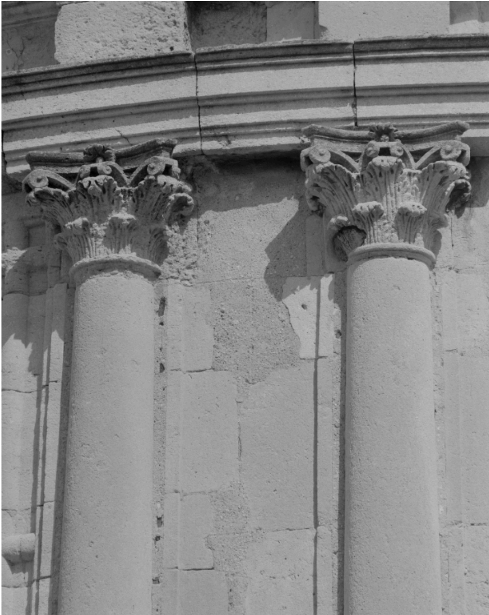
Bâtiment sud. Façade sur la basse-cour. Niche et ordre du troisième niveau.
