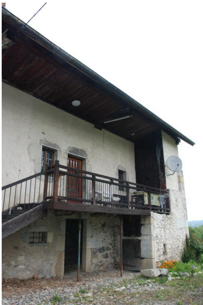
Détail de la façade antérieure : partie habitation.
