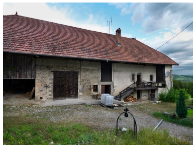
Vue d'ensemble. Phot. Eric Dessert IVR84_20177400768NUCAQ
