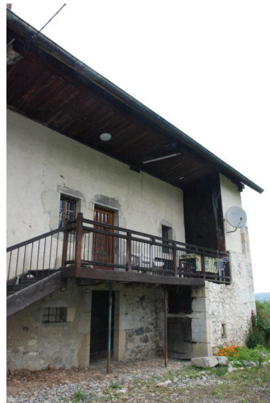
Détail de la façade antérieure : partie habitation. Phot. Caroline Guibaud IVR84_20207400387NUCA
