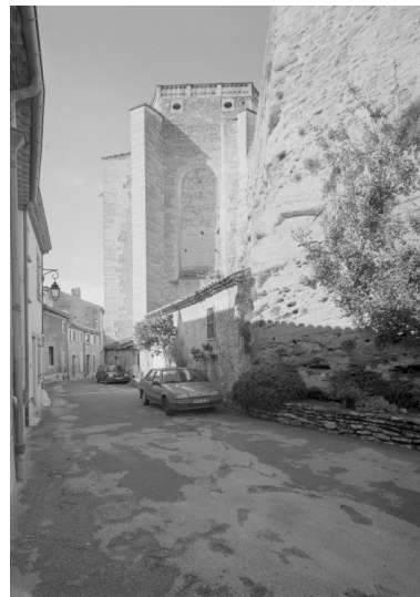
Vue du chevet, dans le site. Phot. Eric Dessert IVR82_20002601004P
