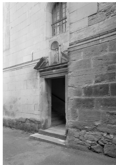
Elévation latérale sur rue, détail : porte d'entrée de l'escalier, à l'étage de soubassement. Phot. Eric Dessert, Phot. Martial Couderette IVR82_20012600064P
