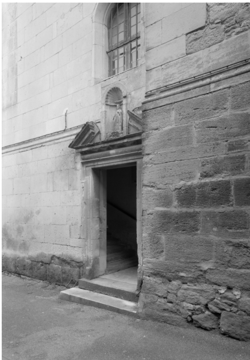
Elévation latérale sur rue, détail : porte d'entrée de l'escalier, à l'étage de soubassement.
