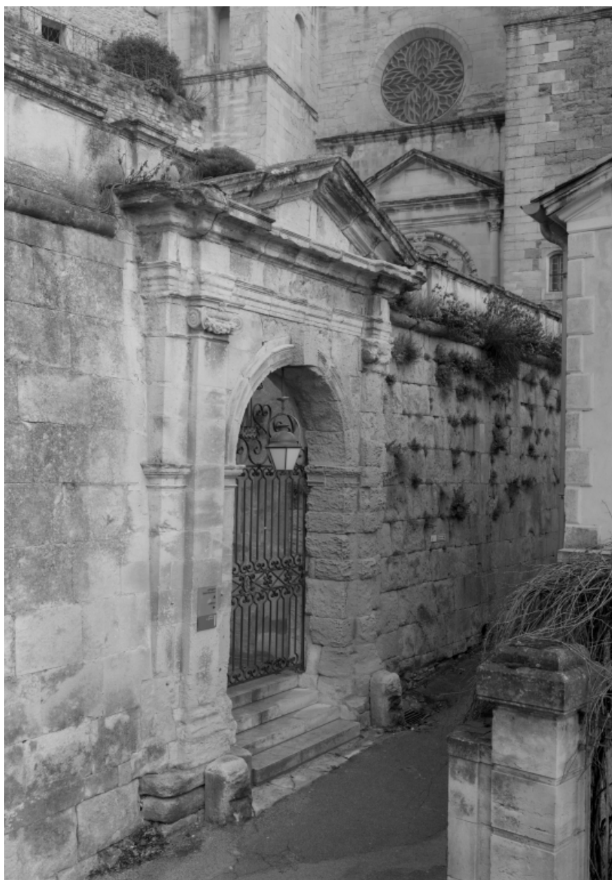
Mur de soutènement du parvis et portail de l'escalier extérieur, sur la rue Saint-Sauveur.
