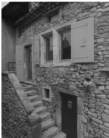
Façade sur la Grand'rue, vue partielle. Phot. Alain Franchella IVR82_19982600941X
