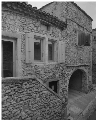
Façade sur la Grand'rue, en cours de restauration. Phot. Alain Franchella IVR82_19982600942X
