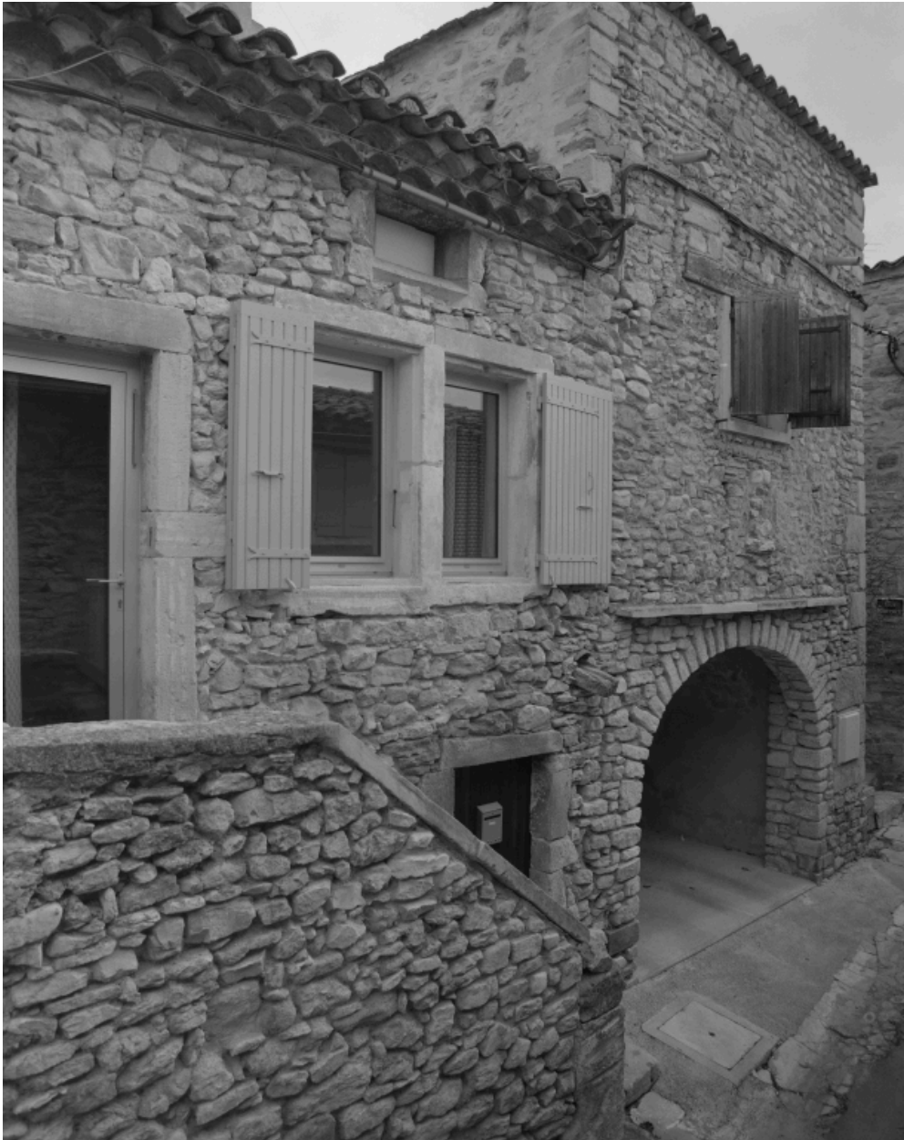
Façade sur la Grand'ruie, en cours de restauration.
