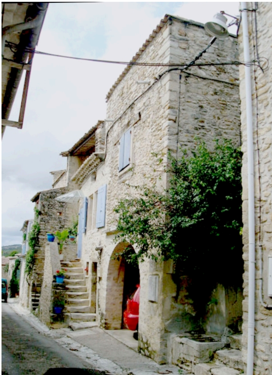
Vue d'ensemble après restauration.
