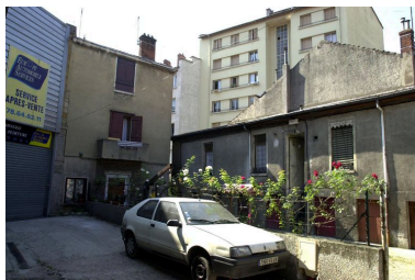
Vue partielle de l'immeuble perpendiculaire à la rue et vue de la maison située en fond de parcelle Phot. François Blanchetière IVR82_20016902247NUCA
