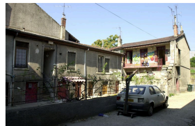
Elévation postérieure de la maison alignée sur rue et élévation antérieure de l'immeuble perpendiculaire à la rue Phot. François Blanchetière IVR82_20016902246NUCA
