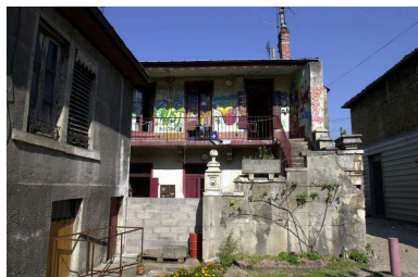
Elévation postérieure de la maison alignée sur rue Phot. François Blanchetière IVR82_20016902260NUCA
