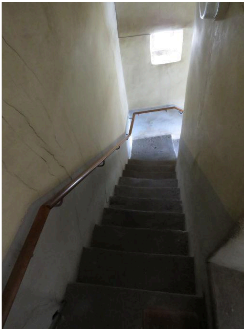
Vue intérieure : escalier
