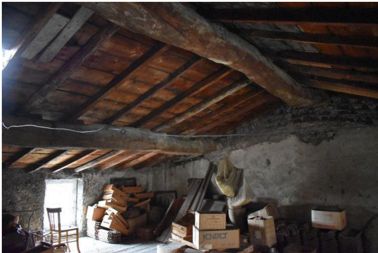
Vue intérieure : comble
