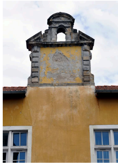
Bâtiment F : élévation sur cour 2, détail du fronton Phot. Catherine Guégan IVR84_20194300071NUCA
