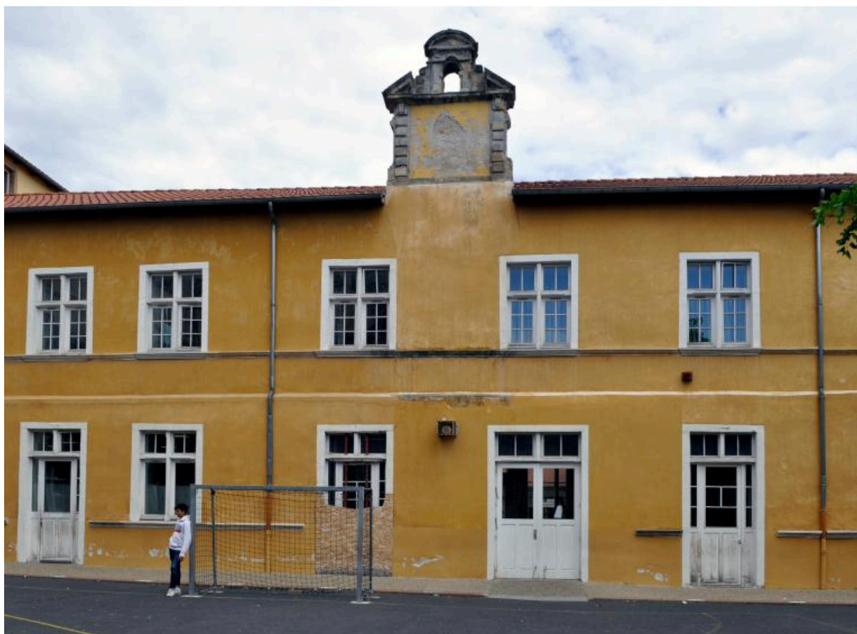
Bâtiment F: élévation sur cour 2, vue partielle
