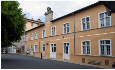
Bâtiment F : élévation sur cour 2, depuis le sud Phot. Catherine Guégan IVR84_20194300062NUCA
