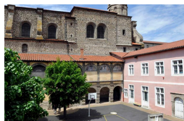
Cour 3, vue depuis le sud-ouest Phot. Catherine Guégan IVR84_20194300044NUCA
