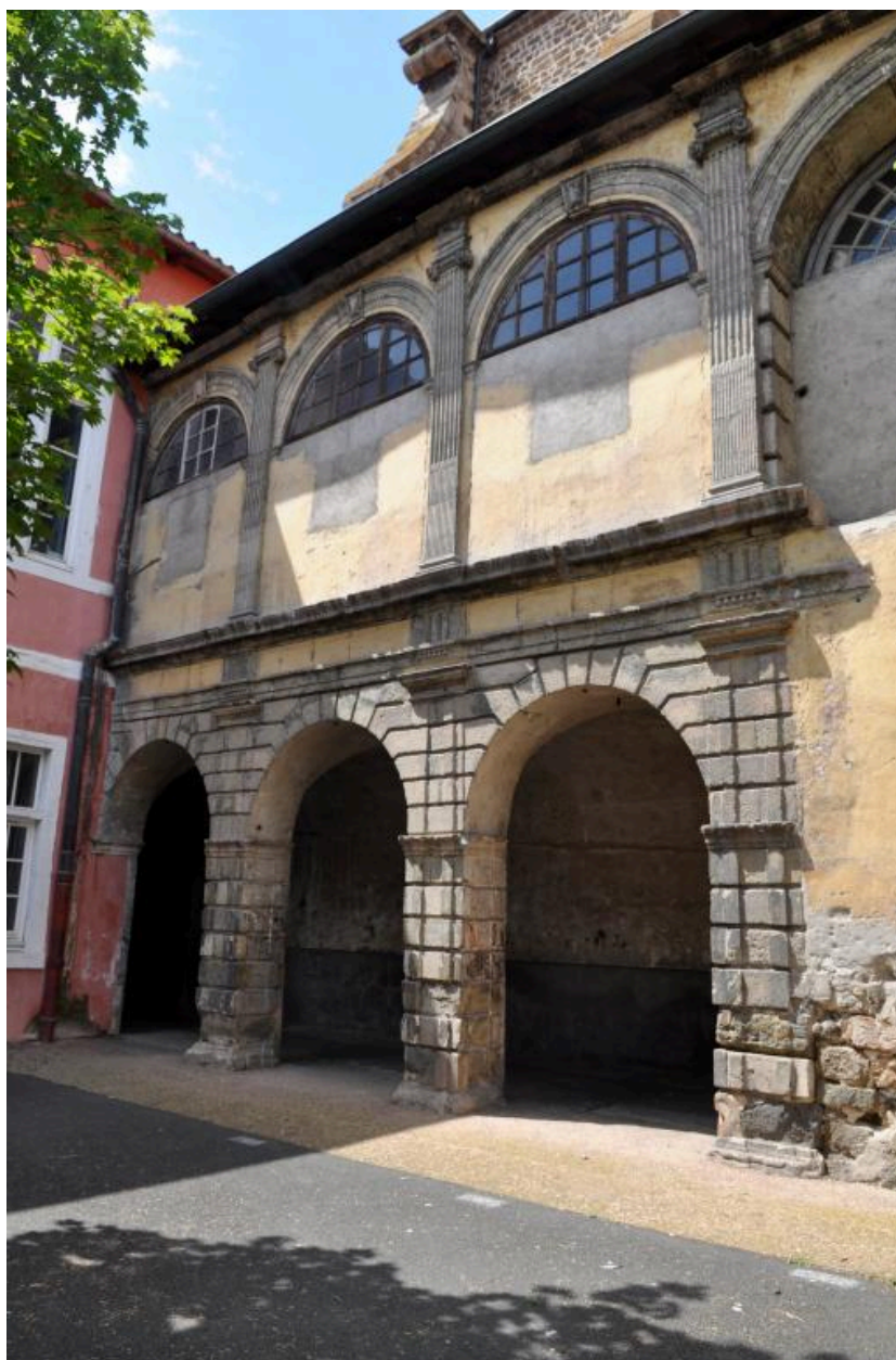
Galerie B : élévation, partie ouest
