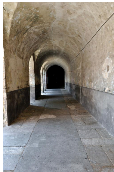
Bâtiment B : portique, depuis l'est Phot. Catherine Guégan IVR84_20194300083NUCA
