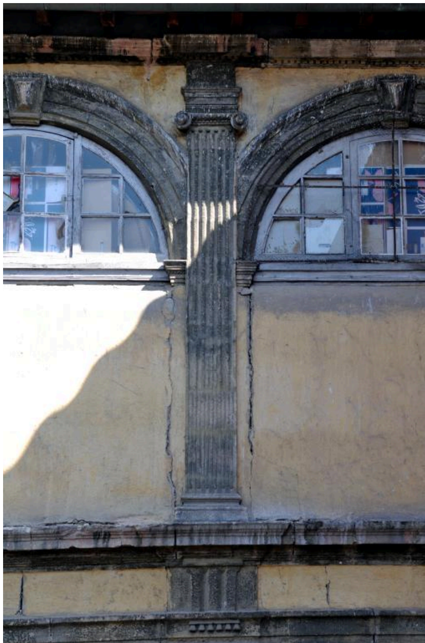
Galerie B : détail d'un pilastre
