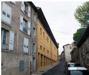
Bâtiment H : élévation sur rue, depuis l'est Phot. Catherine Guégan IVR84_20194300018NUCA
