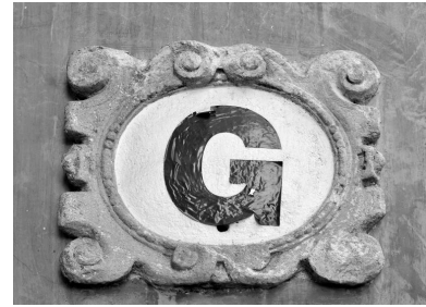
Cartouche au-dessus de l'entrée du bâtiment A côté cour 1 Phot. Catherine Guégan IVR84_20194300054NUCA
