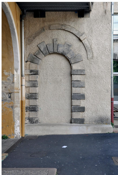
Élévation sud du pavillon ouest de la cour des pères : baie murée avant 1862. Phot. Catherine Guégan IVR84_20254300232NUCA
