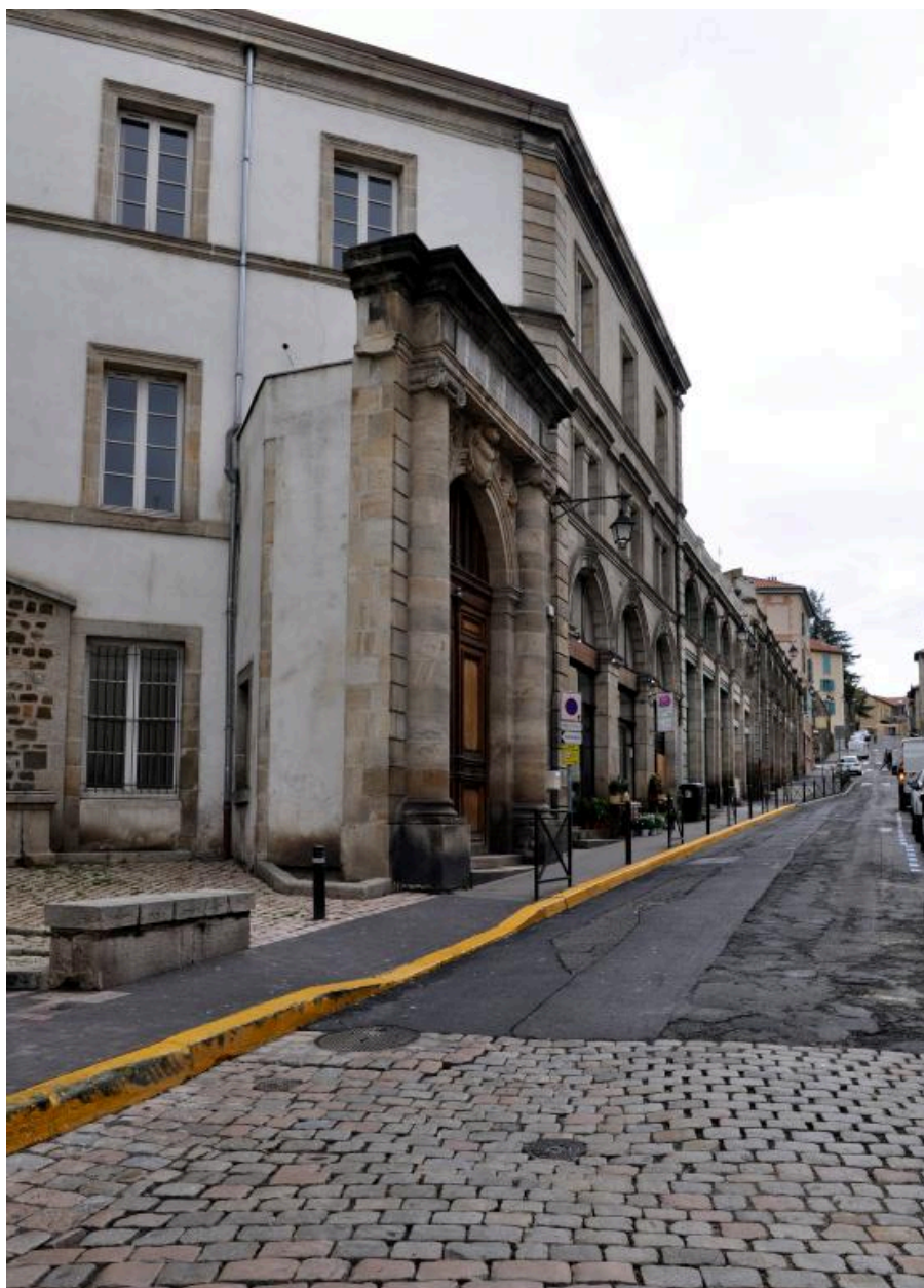
Bâtiment J, depuis le sud
