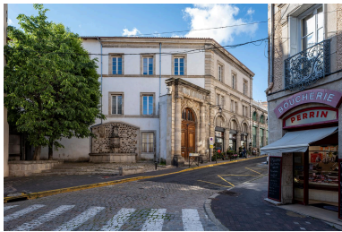
Bâtiment J depuis le sud, en 2025
