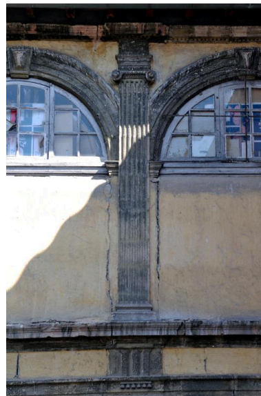
Galerie B : détail d'un pilastre
