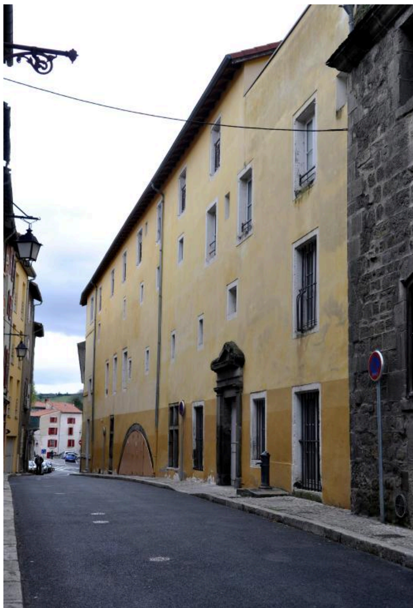
Bâtiment E, élévation sur rue depuis l'ouest
