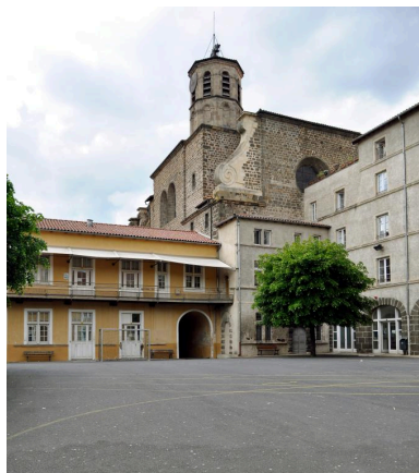
Cour 2, angle nord-ouest Phot. Catherine Guégan IVR84_20194300081NUCA
