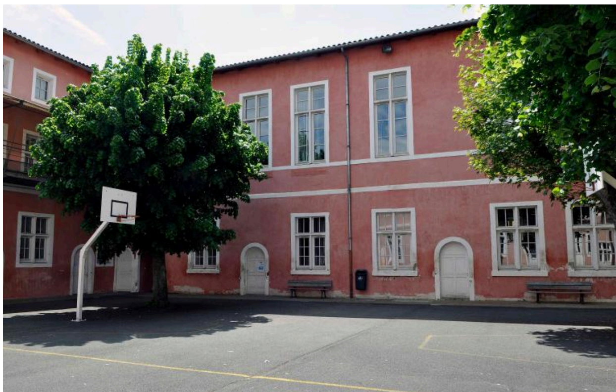
Bâtiment A : élévation sur cour 3 depuis le nord-est
