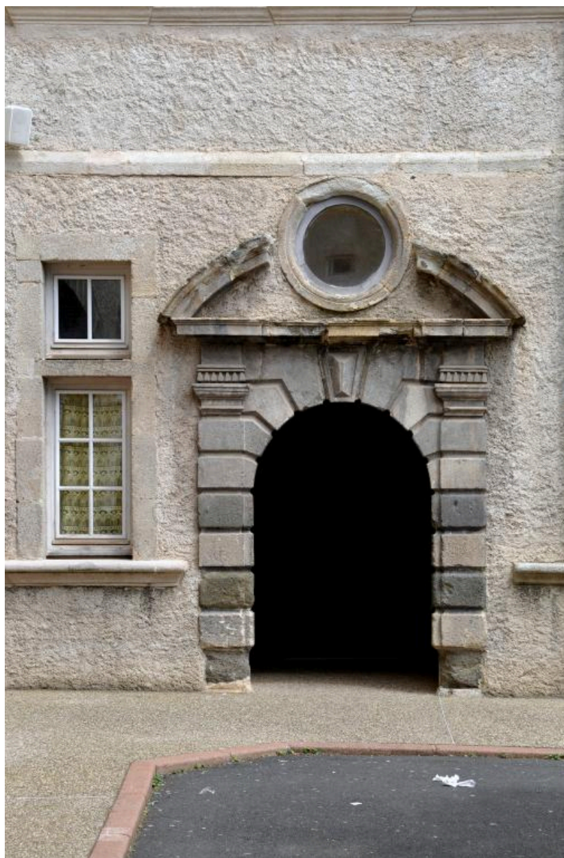
Cour 2 : pavillon est, détail de la porte
