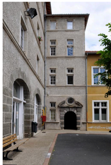
Cour 2, angle nord-est : pavillon faisant jonction entre les bâtiments E et F Phot. Catherine Guégan IVR84_20194300087NUCA
