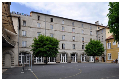
Bâtiment E, élévation sur cour 2 Phot. Catherine Guégan IVR84_20194300035NUCA
