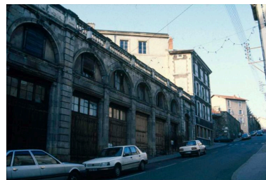
Vue des boutiques et du préau depuis le sud, avant 1990 Phot. Médiathèque de l'Architecture et du Patrimoine IVR84_20194300061NUCAB
