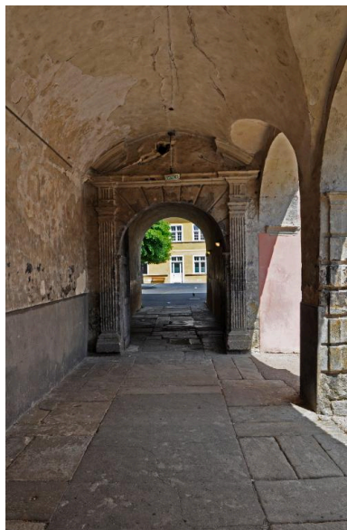
Bâtiment B : portique, passage vers la cour 2 Phot. Catherine Guégan IVR84_20194300077NUCA
