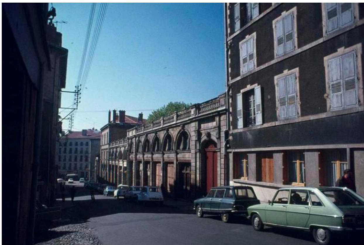
Vue de l'entrée, du préau et des boutiques depuis l'est avant 1990
