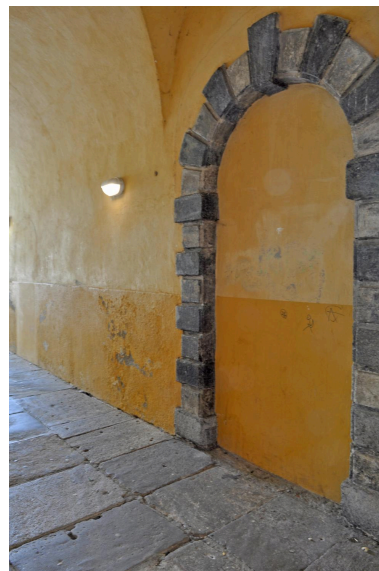
Bâtiment E : baie murée avant 1862 Phot. Catherine Guégan IVR84_20254300233NUCA
