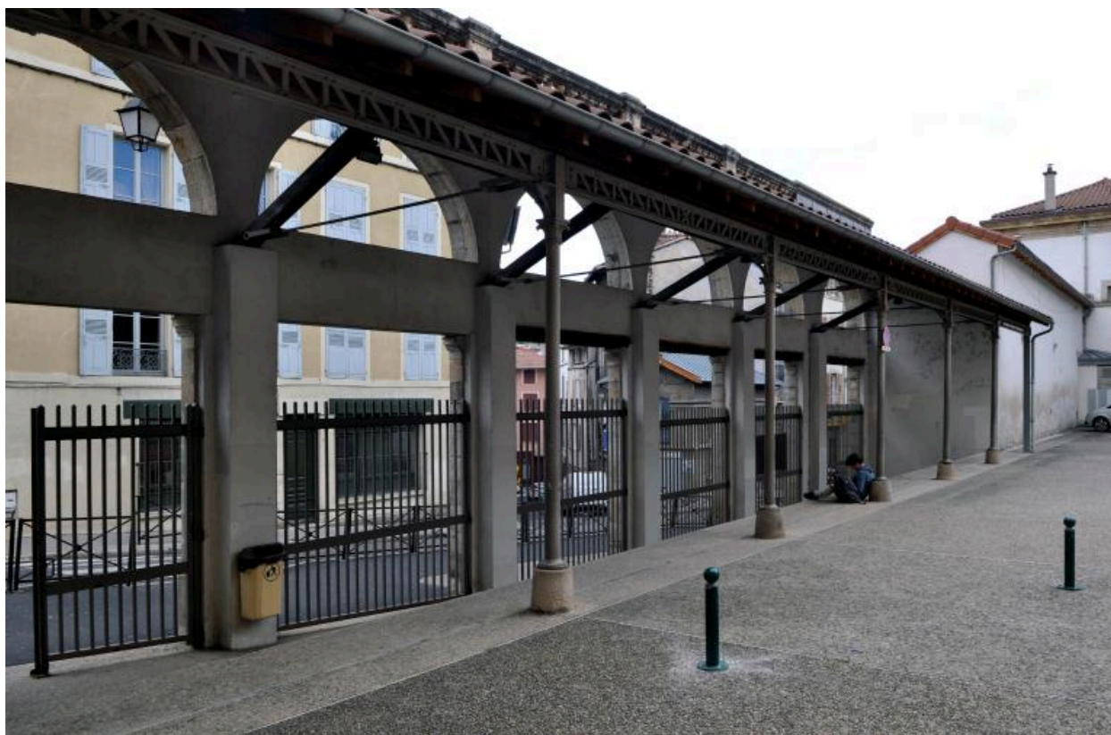
Le préau, vu depuis le nord
