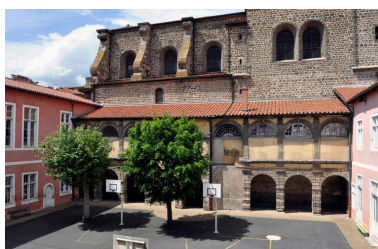
Cour 3, vue d'ensemble depuis le sud Phot. Catherine Guégan IVR84_20194300046NUCA
