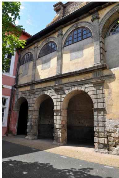
Galerie B : élévation, partie ouest
