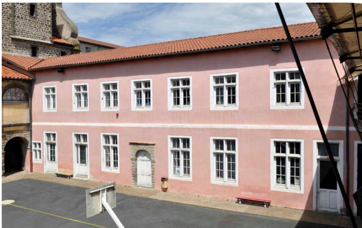
Bâtiment C : élévation sur cour 3 depuis le sud
