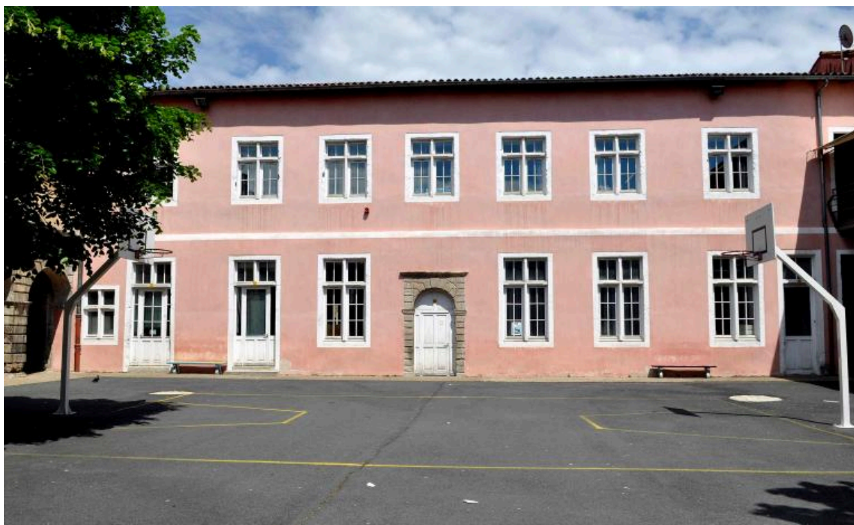
Bâtiment C, élévation sur cour 3
