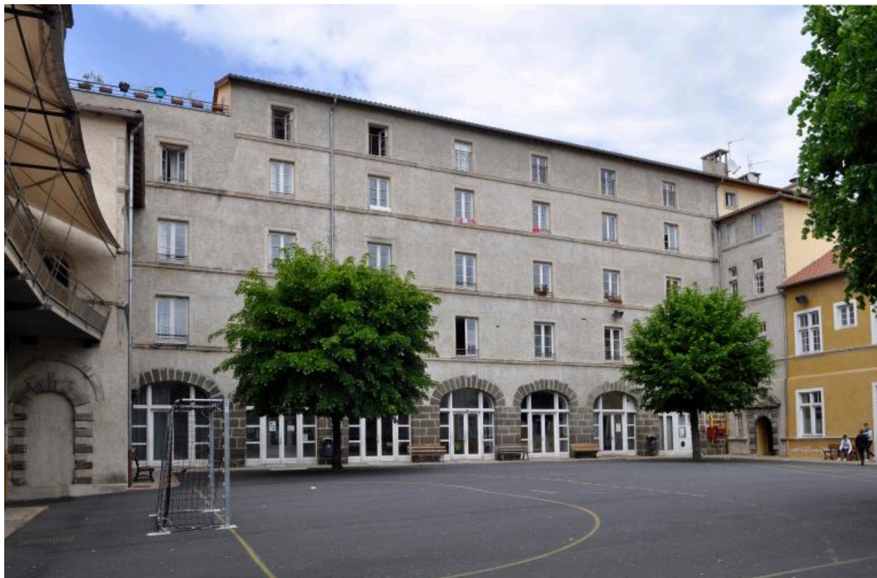
Bâtiment E, élévation sur cour 2
