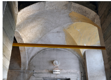
Bâtiment F, rez-de-chaussée : voûte d'arêtes au droit de la 2e volée de l'escalier Phot. Catherine Guégan IVR84_20254300246NUCA
