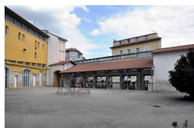
Cour 1, depuis le sud-ouest Phot. Catherine Guégan IVR84_20194300080NUCA
