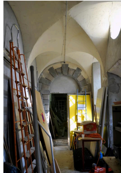
Pavillon ouest : vue de la pièce en rez-de-chaussée depuis le sud et ancienne porte communiquant avec le corps de bâtiment nord de la cour 2 Phot. Catherine Guégan IVR84_20194300117NUCA
