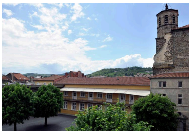
Cour 2, vue générale depuis le nord-est Phot. Catherine Guégan IVR84_20194300040NUCA
