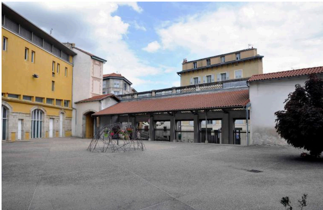
Cour 1, depuis le sud-ouest
