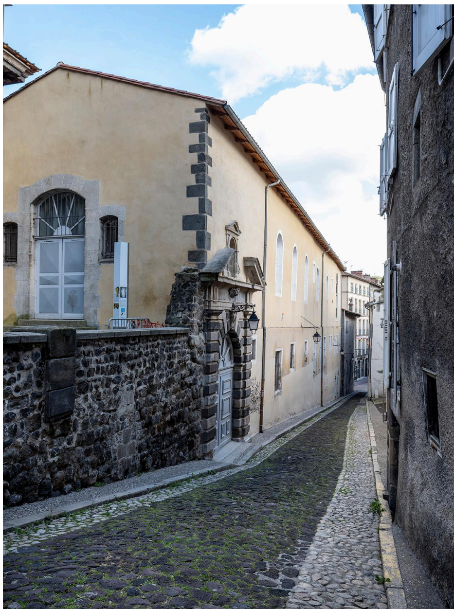
Bâtiment A, élévation sur la rue du Bessat depuis le nord, en 2025
