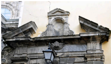
Porte principale : détail du fronton Phot. Catherine Guégan IVR84_20194300009NUCA
