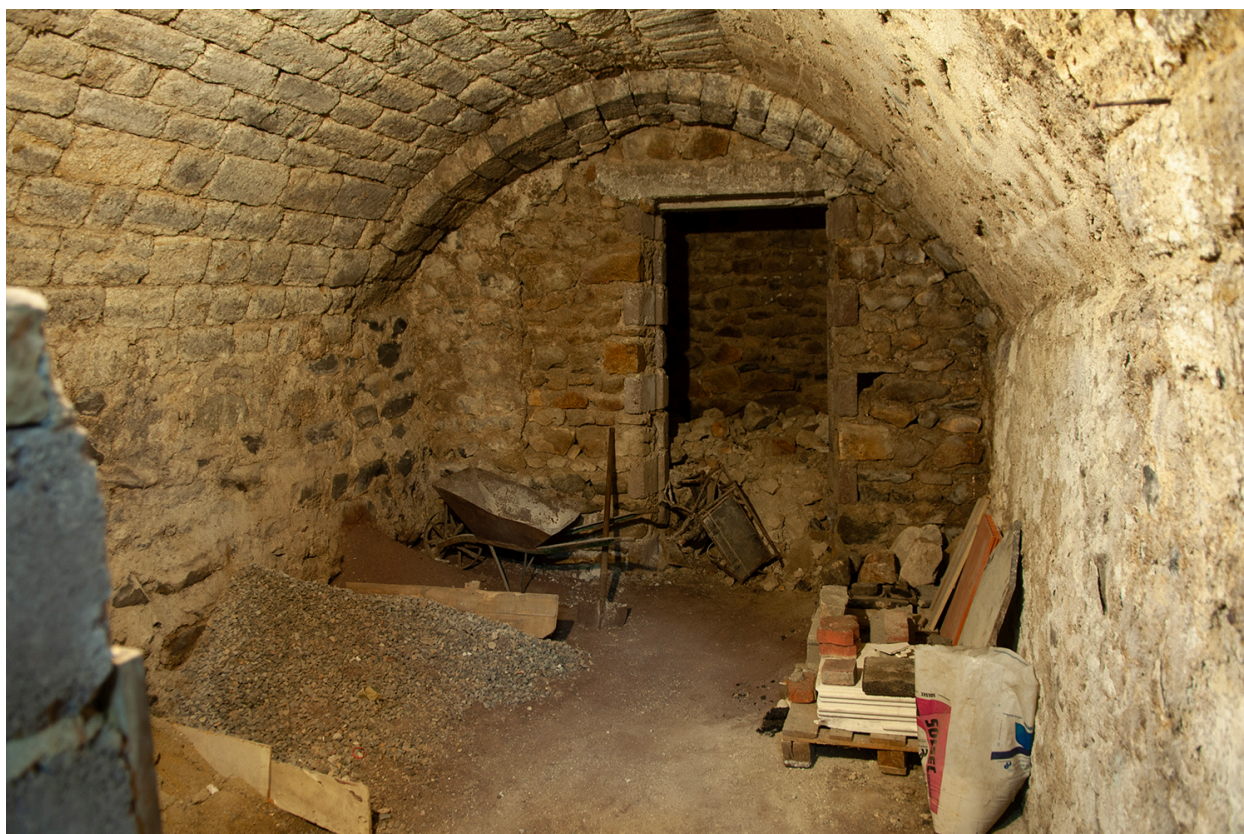
Autre cave sous le bâtiment F
