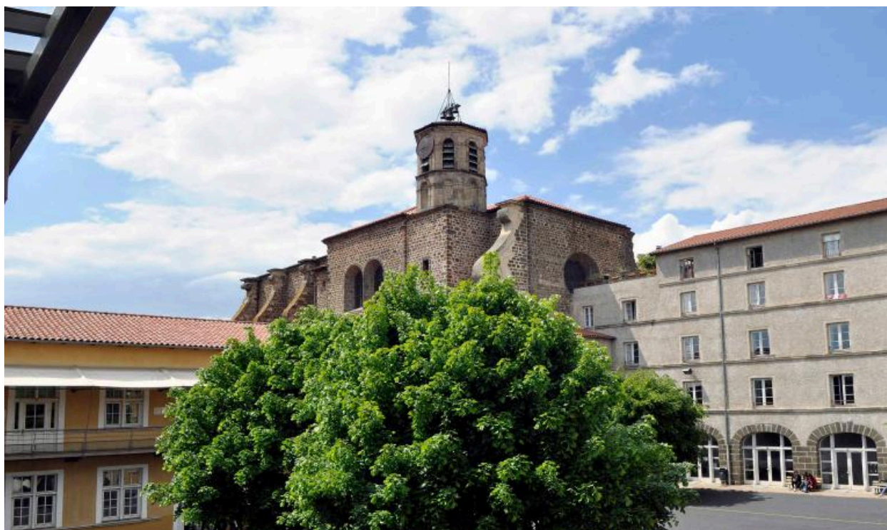
Cour 2, vue générale depuis le sud-est
