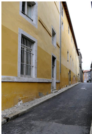
Bâtiment E, élévation sur rue depuis l'est Phot. Catherine Guégan IVR84_20194300022NUCA
