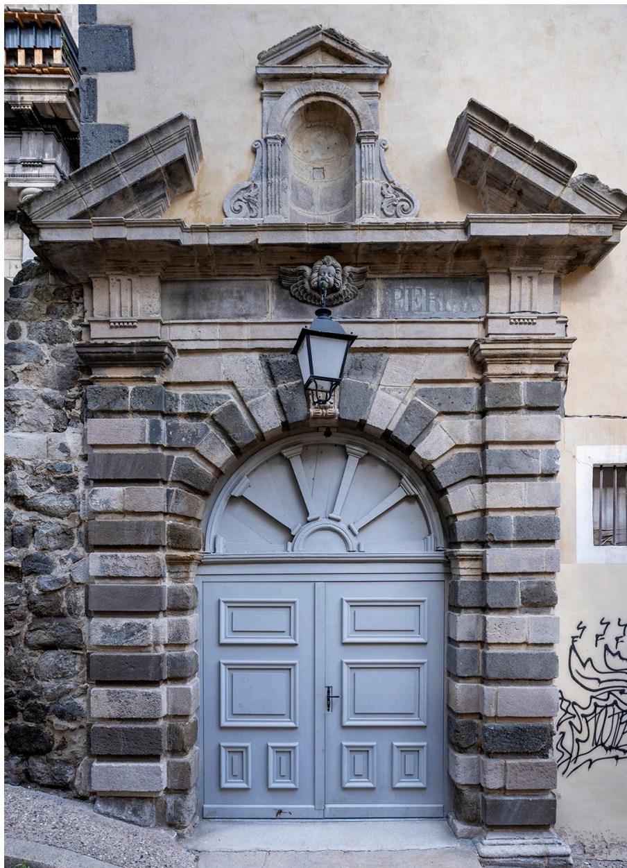
Collège jésuite : porte principale rue du Bessat, vue de de face
