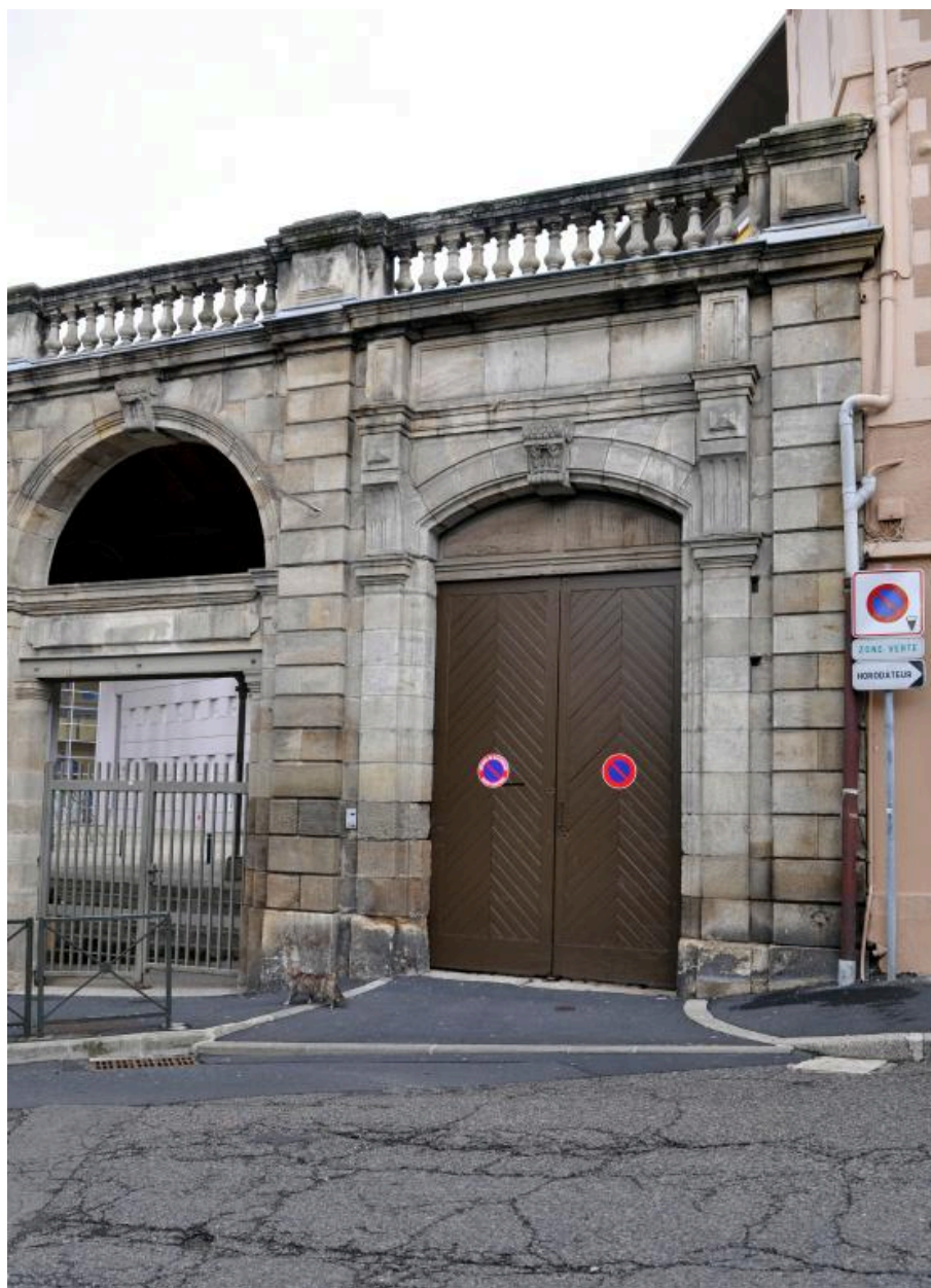
Entrée actuelle du collège, rue Général-Lafayette
