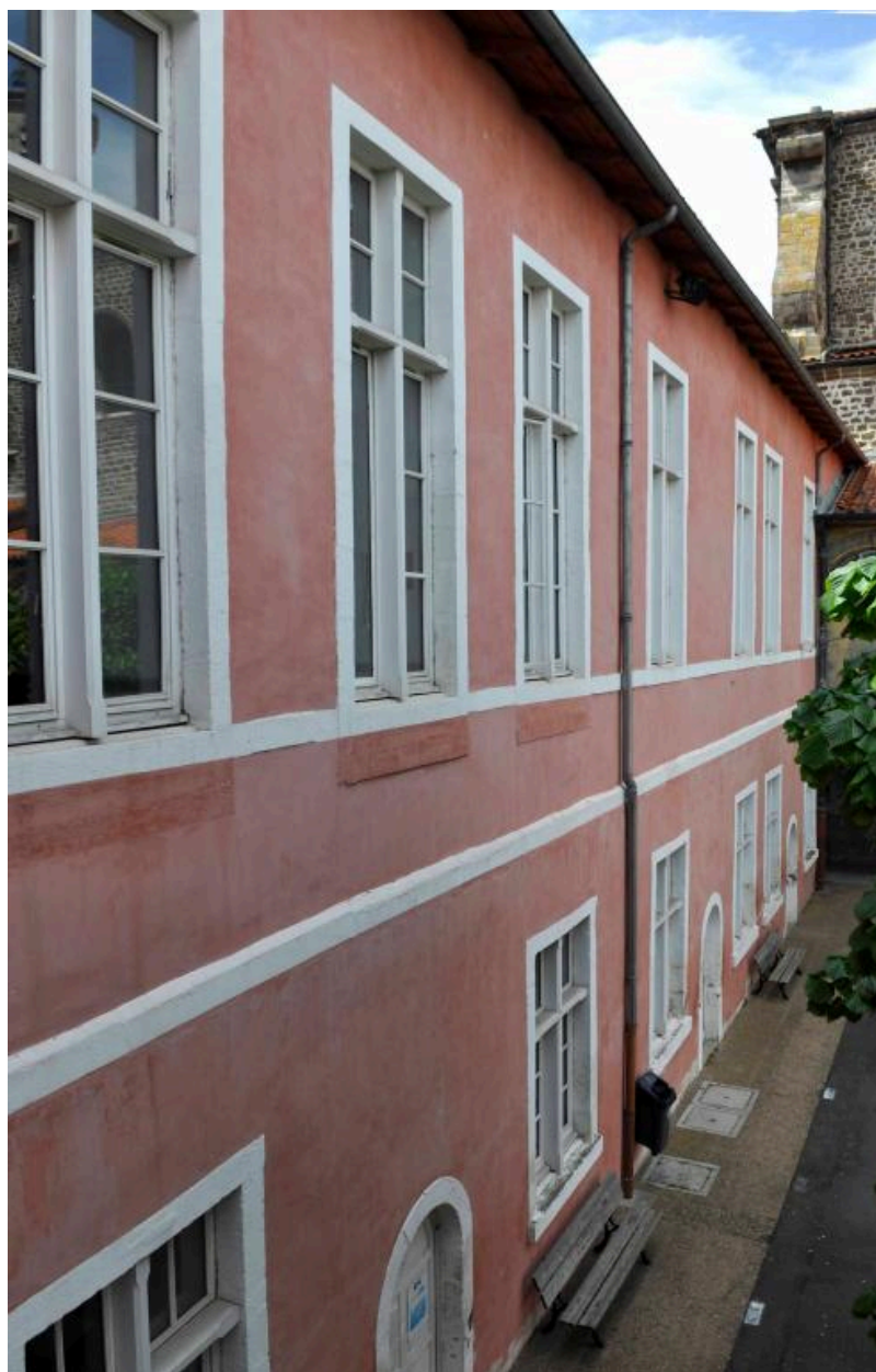
Bâtiment A : élévation sur cour 3
