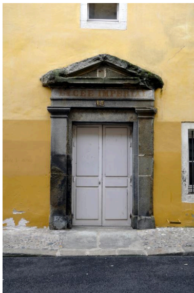
Bâtiment E : porte (17e s.) rue Saint-François-Régis avec inscription LYCEE IMPERIAL sur l'entablement ; elle donne accès au 1er étage du bâtiment E. Phot. Catherine Guégan IVR84_20194300023NUCA
