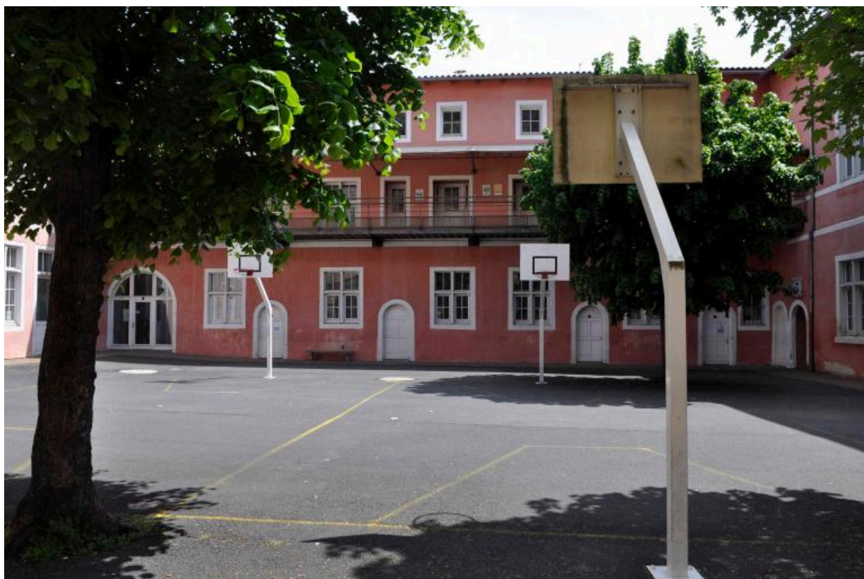
Bâtiment A : élévation sur cour 3
