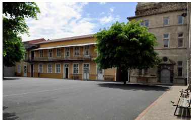
Bâtiment C : élévation sur cour 2, depuis le nord-est Phot. Catherine Guégan IVR84_20194300090NUCA
