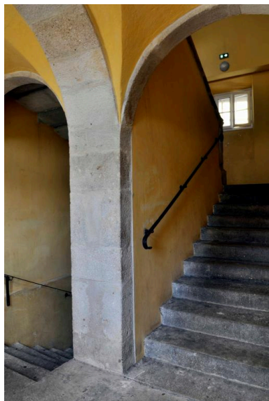
Bâtiment F : escalier, vue depuis le premier repos Phot. Catherine Guégan IVR84_20194300038NUCA
