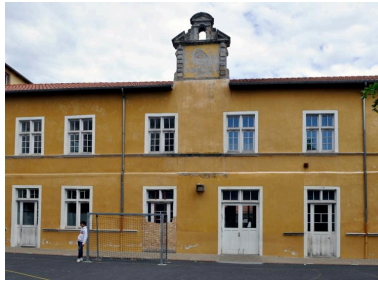
Bâtiment F: élévation sur cour 2, vue partielle Phot. Catherine Guégan IVR84_20194300070NUCA
