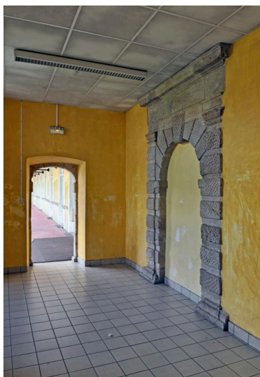
Bâtiment E, 1er étage : porte murée, ancien accès sud à l'église par le 1er étage de la galerie de la cour des classes Phot. Catherine Guégan IVR84_20194300103NUCA
