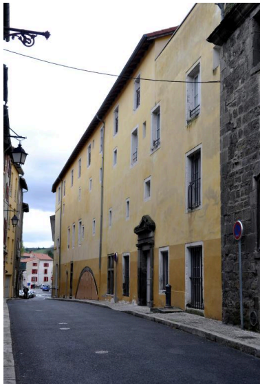
Bâtiment E, élévation sur rue depuis l'ouest Phot. Catherine Guégan IVR84_20194300008NUCA
