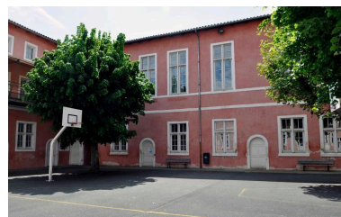
Bâtiment A : élévation sur cour 3 depuis le nord-est Phot. Catherine Guégan IVR84_20194300051NUCA
