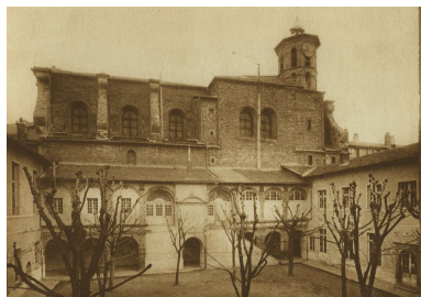
La cour des classes vue depuis le sud, 1er quart du 20e siècle ? ; l'escalier menant au 1er étage de la galerie n'est pas encore démoli (Charenton-le-Pont, MPP, 12R011382) Autr. auteur inconnu, Phot. Médiathèque de l'Architecture et du Patrimoine IVR84_20254300028NUC
