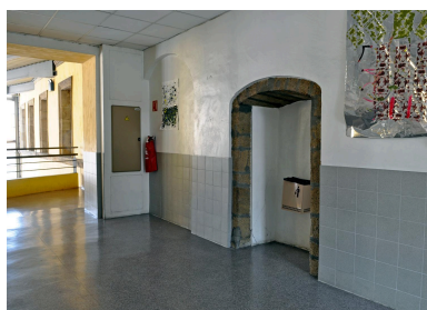
Bâtiment F, 1er étage : baies de l'ancien collège murées (ouvertures entre deux salles du corps de bâtiment est de la cour des pères) Phot. Catherine Guégan IVR84_20254300234NUCA
