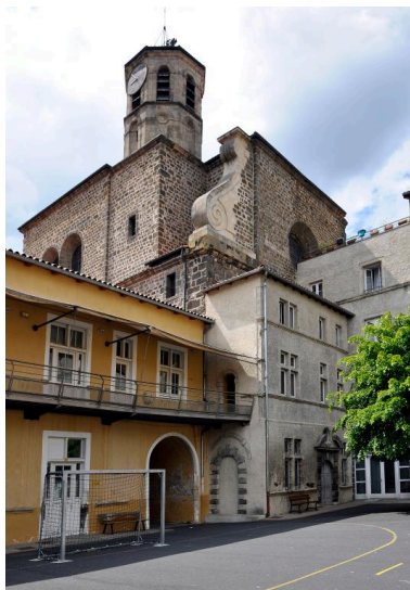
Cour 2, angle nord-ouest, depuis le sud : pavillon faisant jonction entre les bâtiments C et E Phot. Catherine Guégan IVR84_20194300086NUCA
