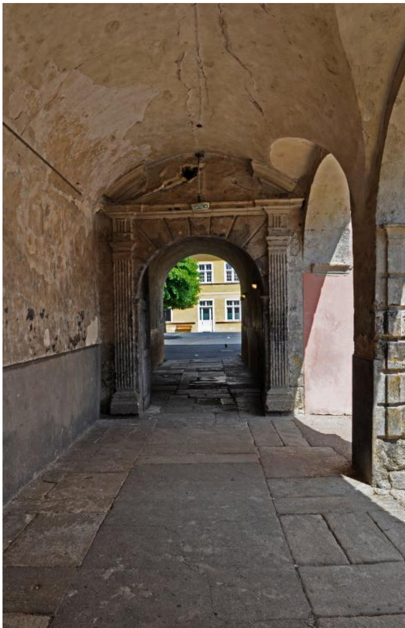
Bâtiment B : portique, passage vers la cour 2
