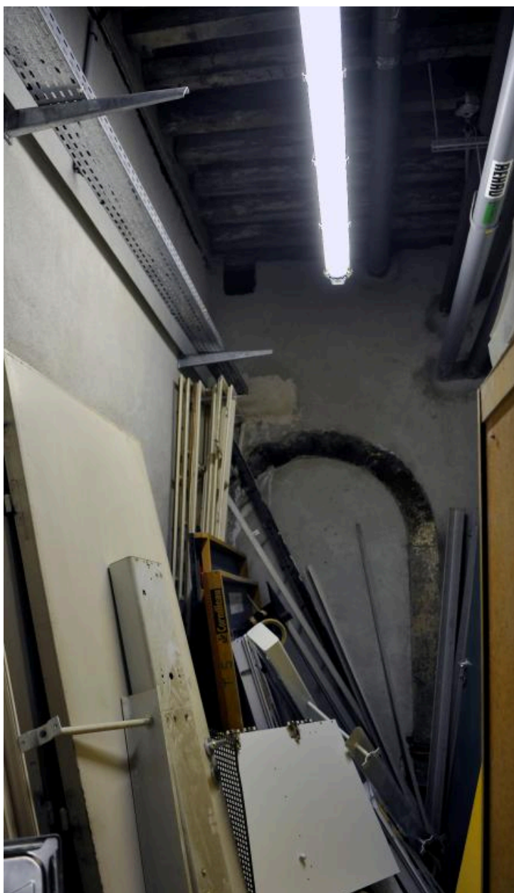
Bâtiment E, rez-de-chaussée : ancien couloir
