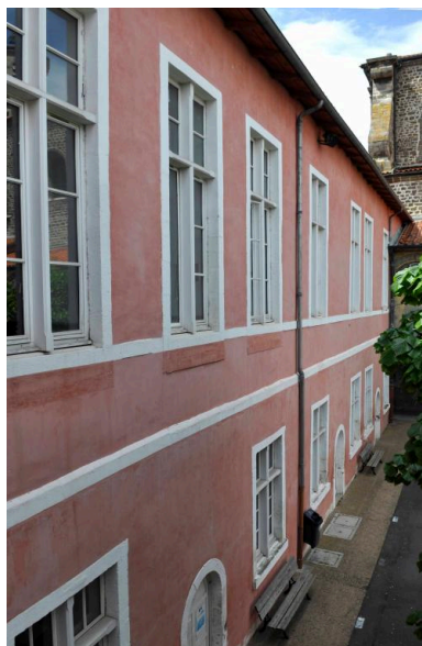
Bâtiment A : élévation sur cour 3 Phot. Catherine Guégan IVR84_20194300047NUCA
