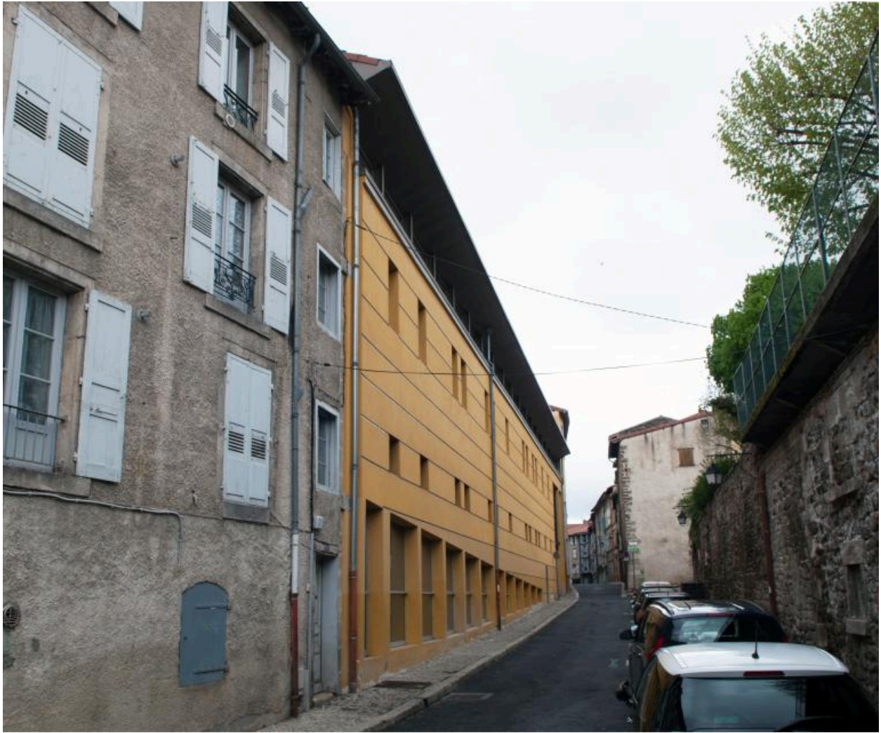
Bâtiment H : élévation sur rue, depuis l'est
