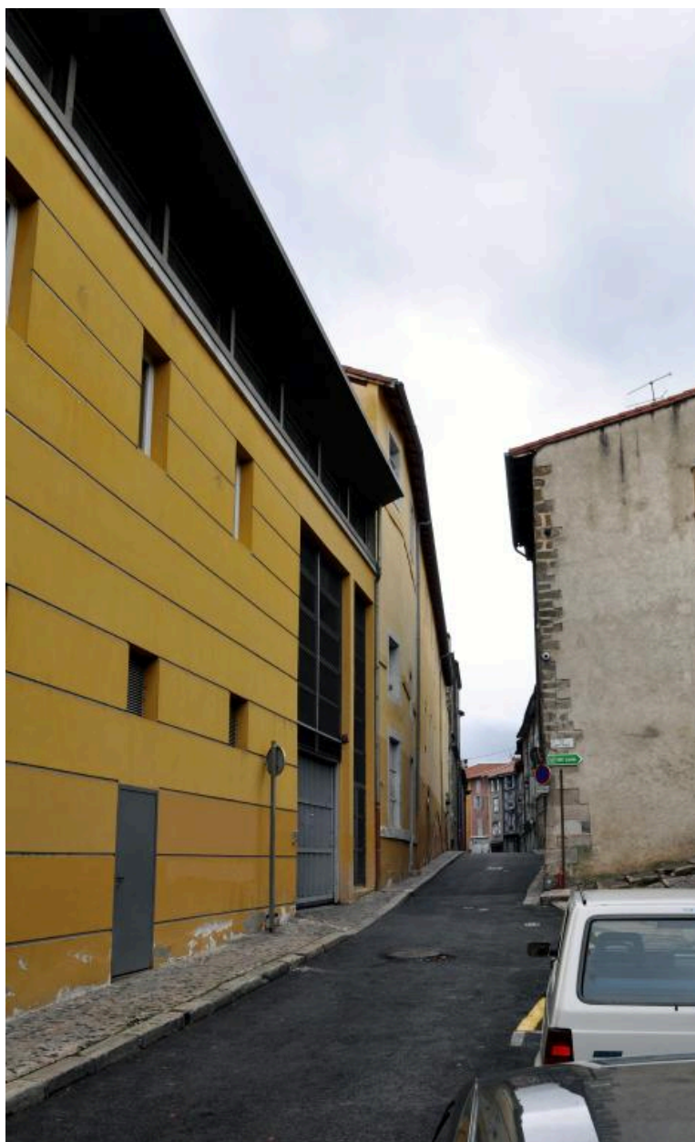
Elévations postérieures, rue Saint François-Régis : bâtiment H et bâtiment E en arrière-plan
