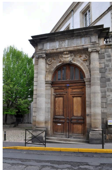
Ancienne porte d'entrée du lycée, rue du Général-Lafayette Phot. Catherine Guégan IVR84_20194300021NUCA
