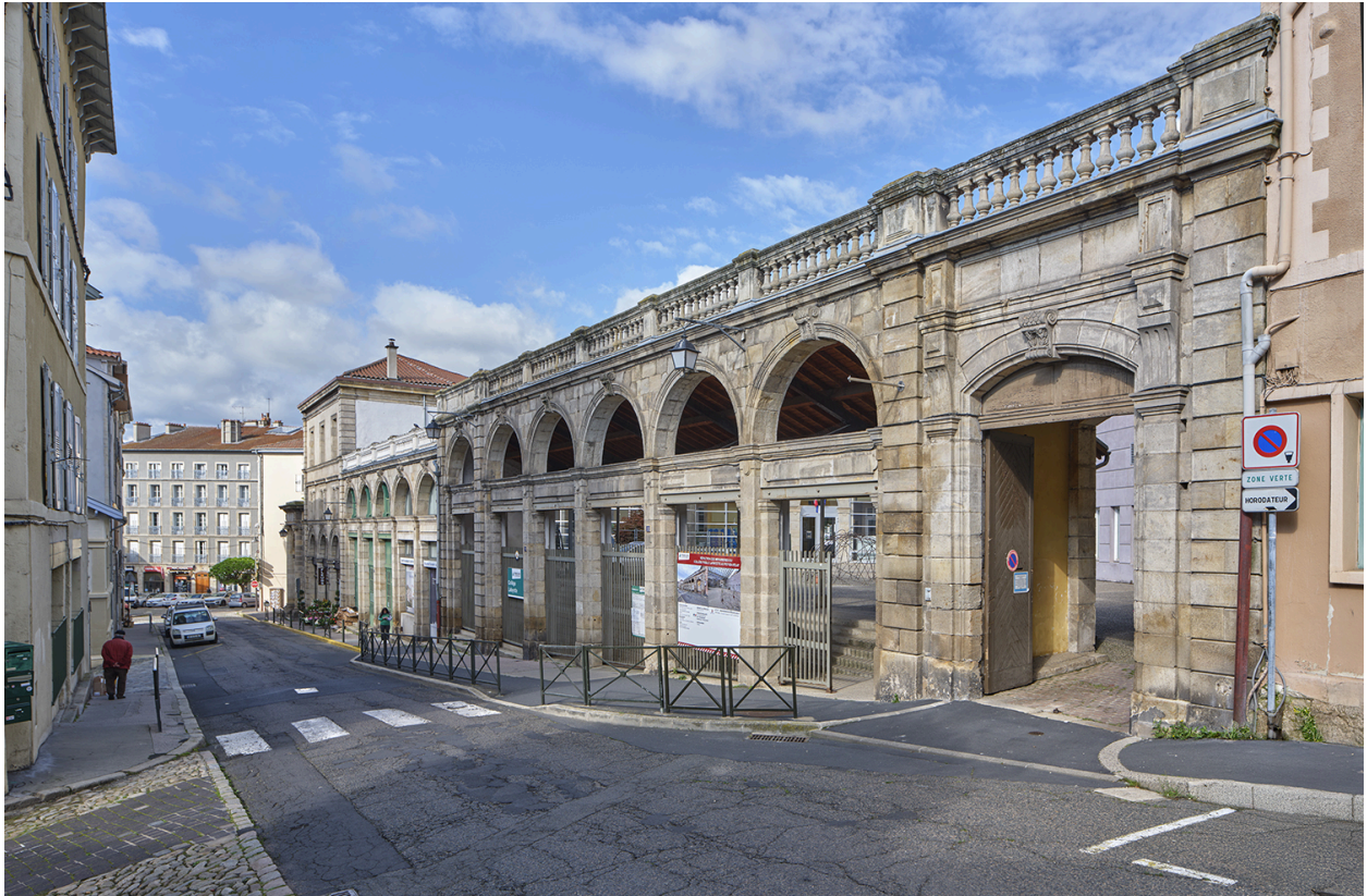
Portail, préau, boutiques et bâtiment J vus depuis l'est, en 2025
