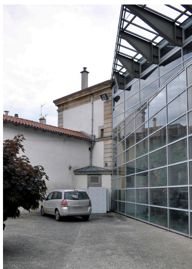
Cour 1, angle sud ; à l'arrière plan, bâtiment J Phot. Catherine Guégan IVR84_20254300237NUCA
