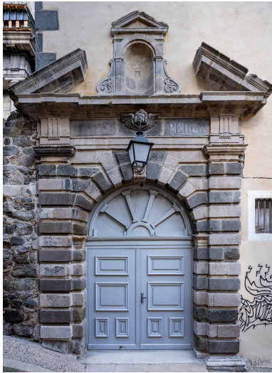
Collège jésuite : porte principale rue du Bessat, vue de de face Phot. Michel Pérès IVR84_20254300117NUCA
