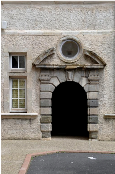
Cour 2 : pavillon est, détail de la porte Phot. Catherine Guégan IVR84_20194300088NUCA
