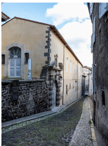
Bâtiment A, élévation sur la rue du Bessat depuis le nord, en 2025 Phot. Michel Pérès IVR84_20254300118NUCA
