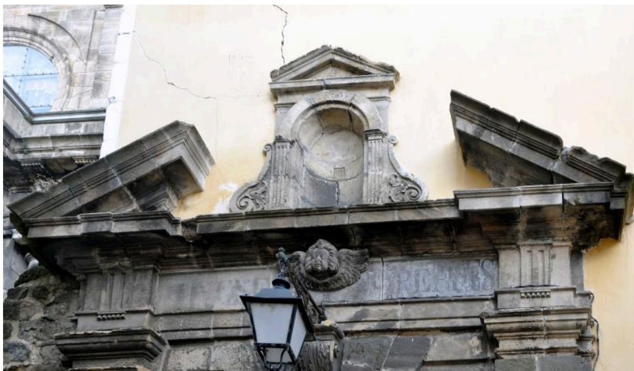
Porte principale : détail du fronton
