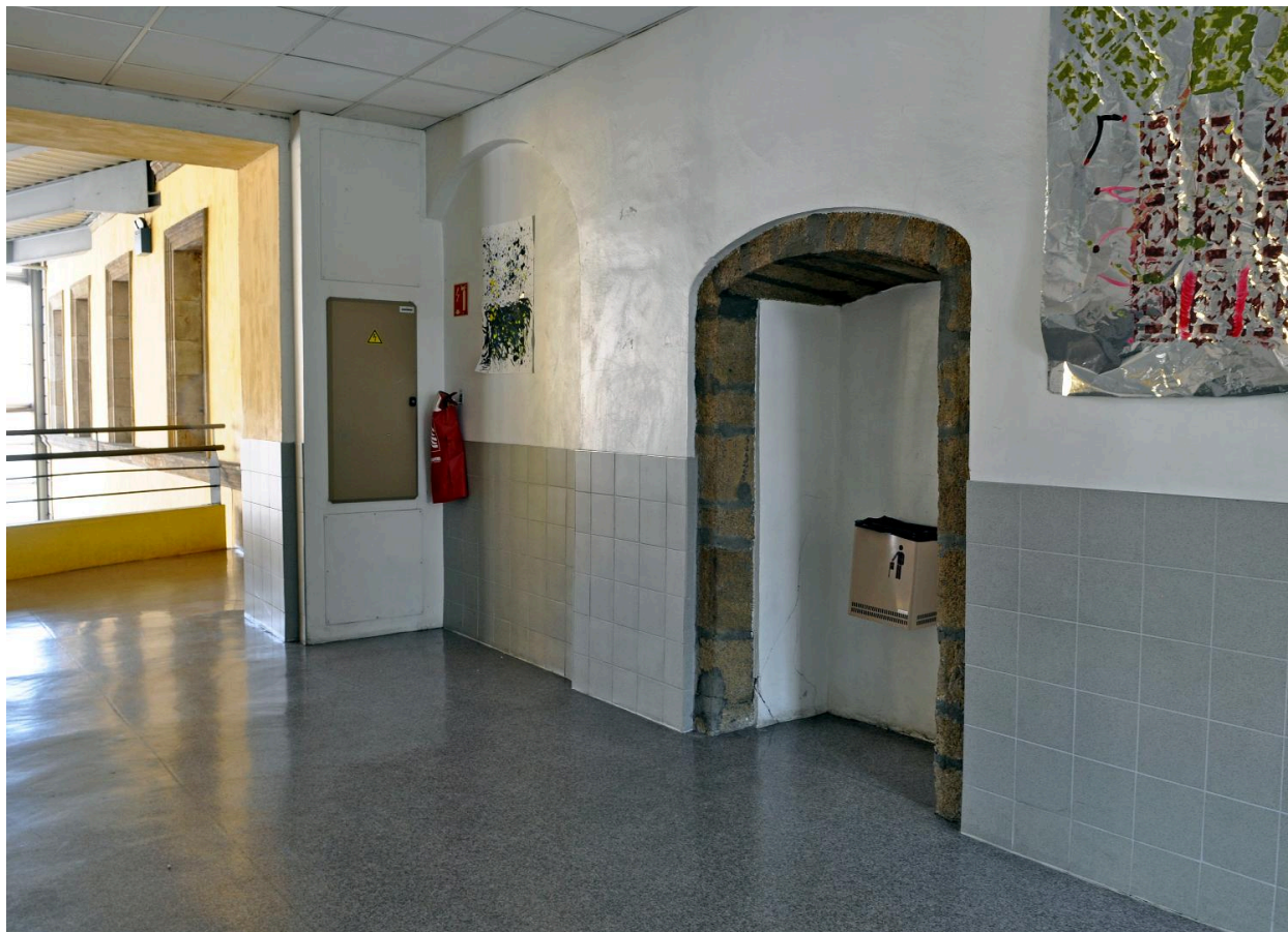
Bâtiment F, 1er étage : baies de l'ancien collège murées (ouvertures entre deux salles du corps de bâtiment est de la cour des pères)
