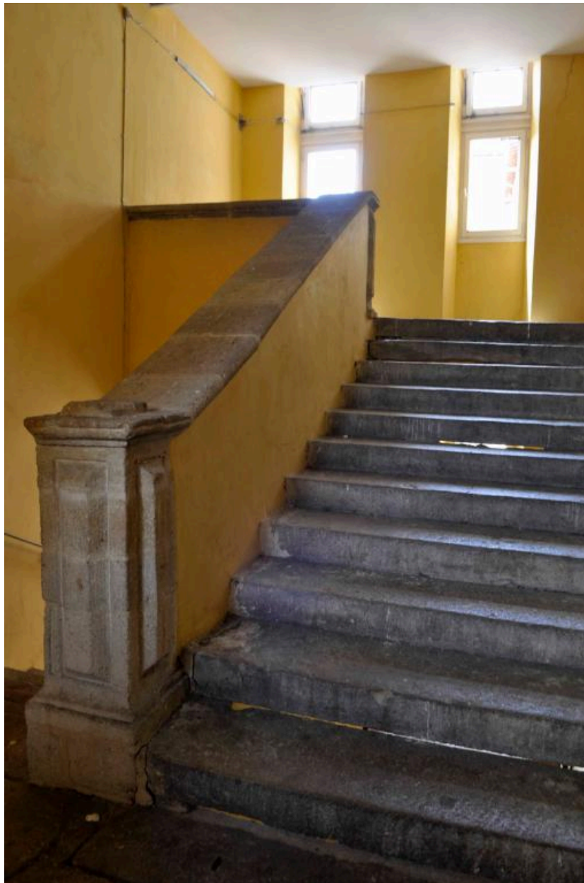
Bâtiment F : escalier, dernière volée
