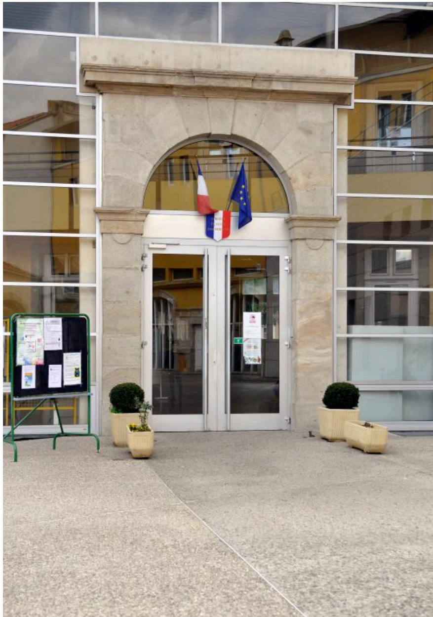
Porte d'entrée du collège sur cour 1
