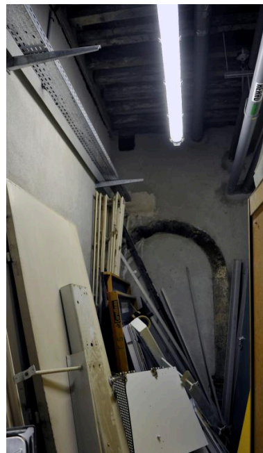
Bâtiment E, rez-de-chaussée : ancien couloir Phot. Catherine Guégan IVR84_20194300116NUCA
