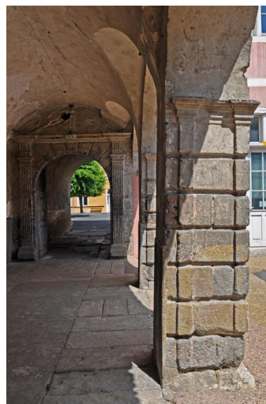
Bâtiment B : portique, détail des pilastres à bossage
