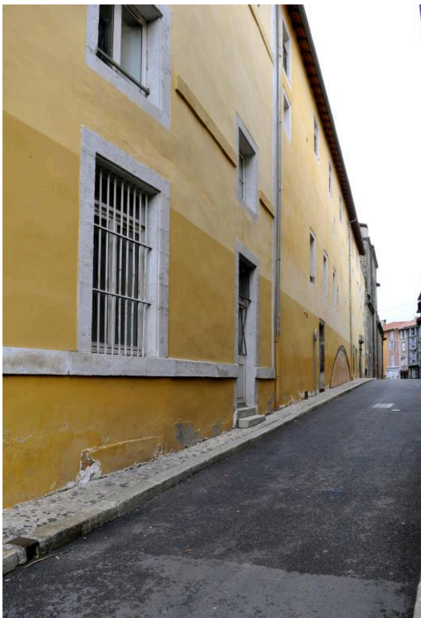
Bâtiment E, élévation sur rue depuis l'est
