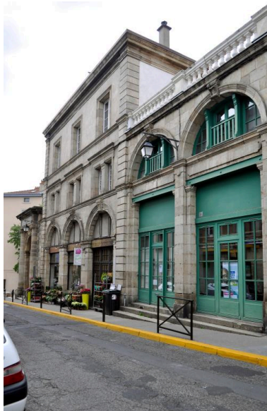
Bâtiment J, élévation sur la rue de Général Lafayette, depuis l'ouest
