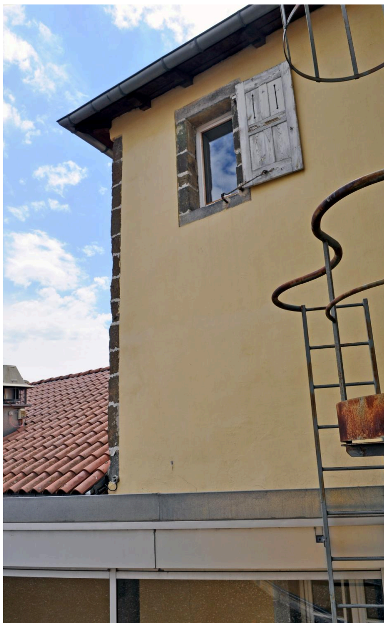
Bâtiment F, pavillon est de la cour 2 : dernier niveau de la tour d'escalier, vu de puis la cour 1
