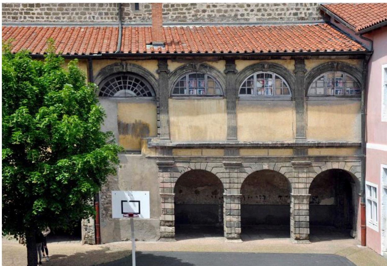
Galerie B : élévation partie est
