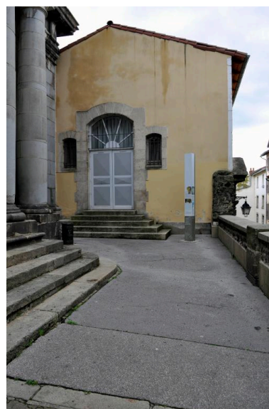
Bâtiment A : ancienne entrée de la bibliothèque municipale au niveau du parvis de l'église, desservant le 1er étage Phot. Catherine Guégan IVR84_20194300028NUCA
