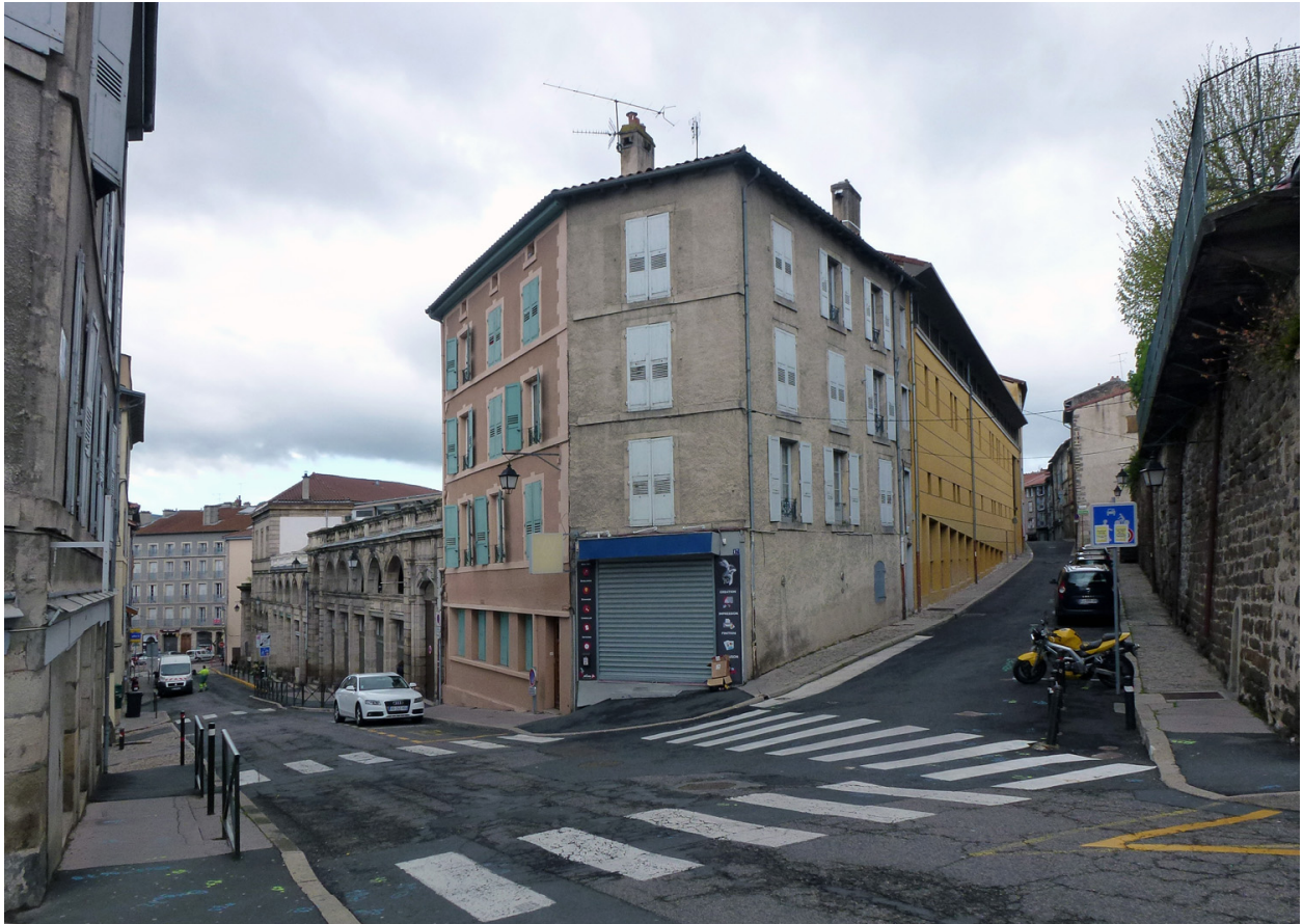
Vue générale depuis le nord-est
