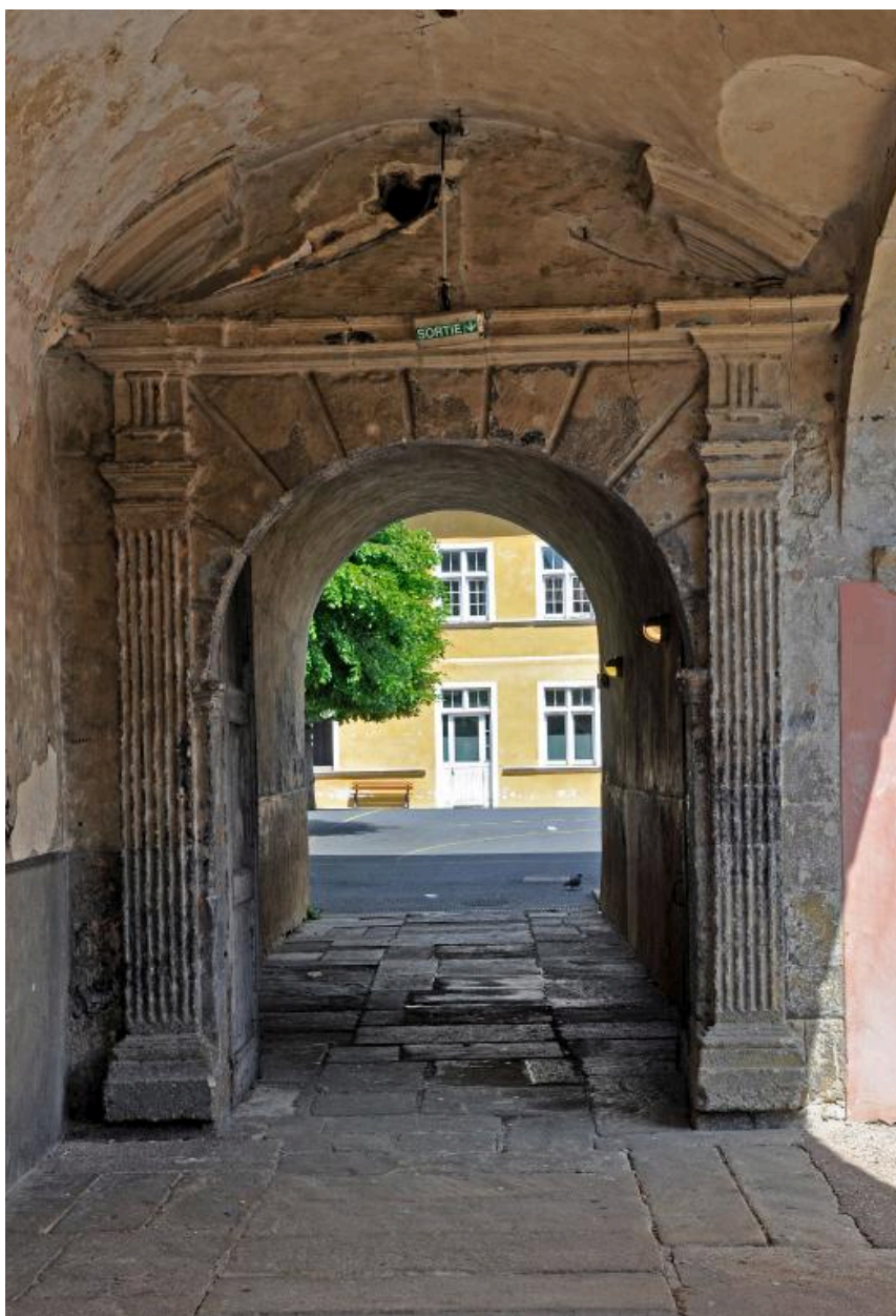
Bâtiment B : détail de la porte du passage vers la cour 2
