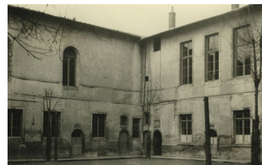
Angle sud-ouest de la cour des classes, 1er quart du 20e siècle ? (Charenton-le-Pont, MPP, 12R011431) Autr. auteur inconnu, Phot. Médiathèque de l'Architecture et du Patrimoine IVR84_20254300030NUC
