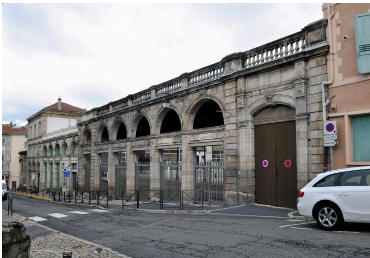
Portail, préau, boutiques et bâtiment J vus depuis l'est, en 2019
