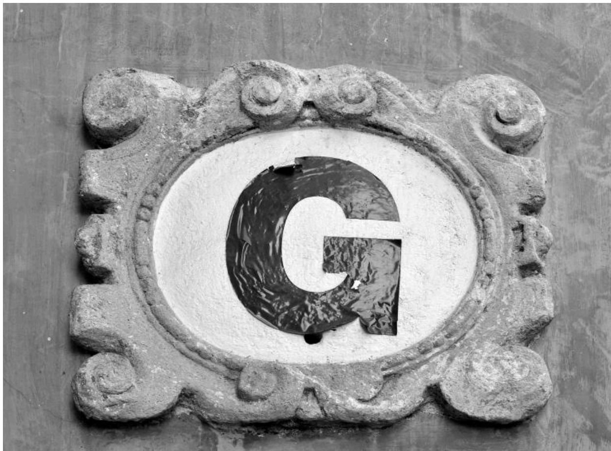
Cartouche au-dessus de l'entrée du bâtiment A côté cour 1
