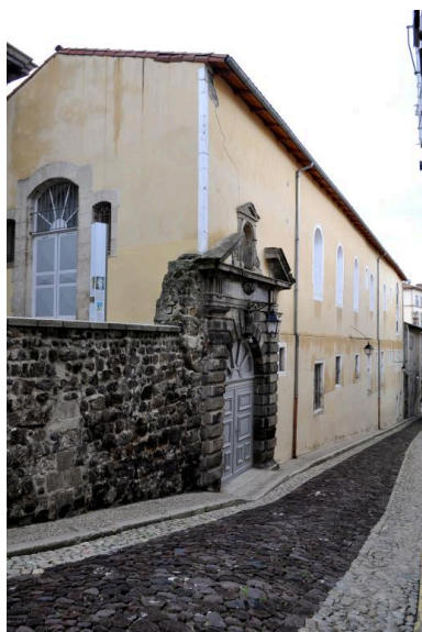
Bâtiment A, élévation sur la rue du Bessat depuis le nord Phot. Catherine Guégan IVR84_20194300014NUCA
