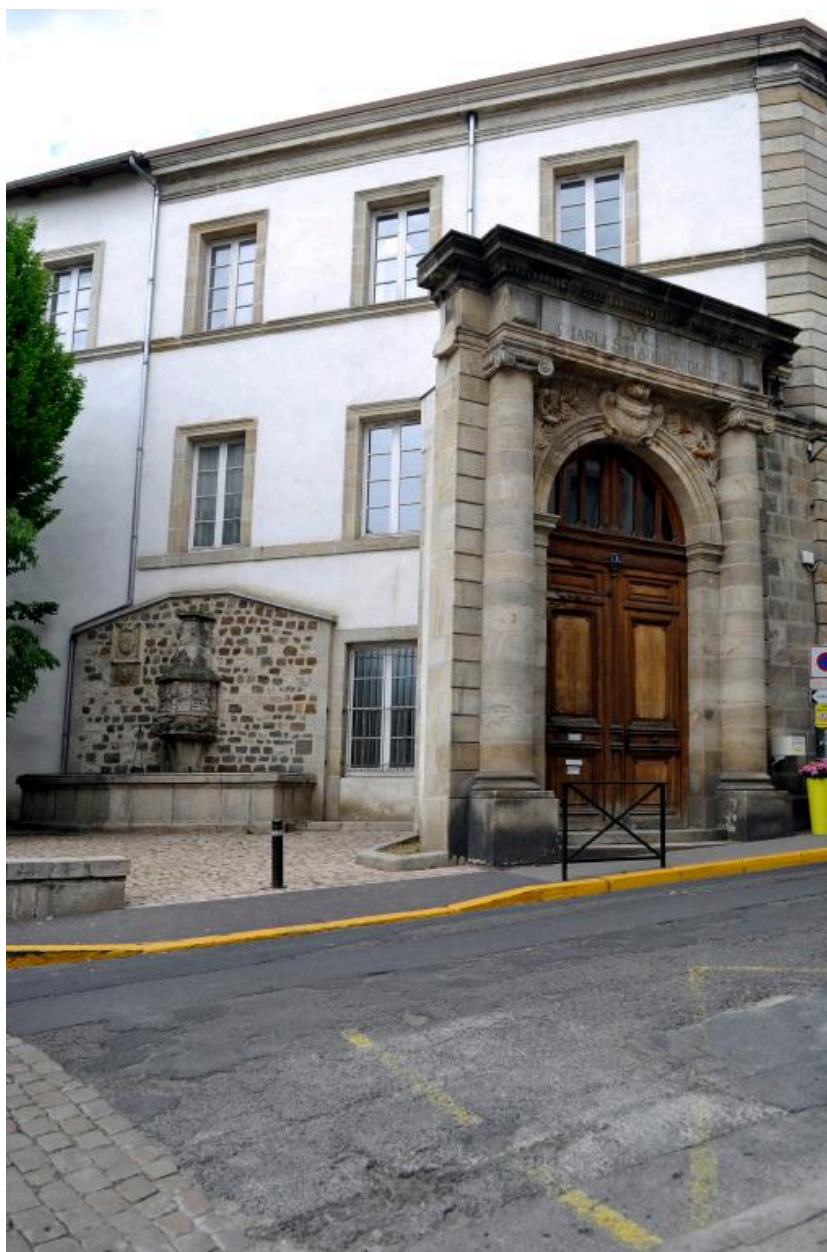
Ancienne entrée du lycée, bâtiment J et fontaine du Théron (13e s.)
