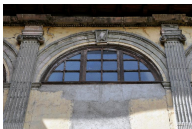
Bâtiment B : galerie, détail d'une baie
