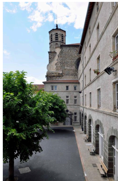
Cour 2, partie nord depuis l'est Phot. Catherine Guégan IVR84_20194300037NUCA
