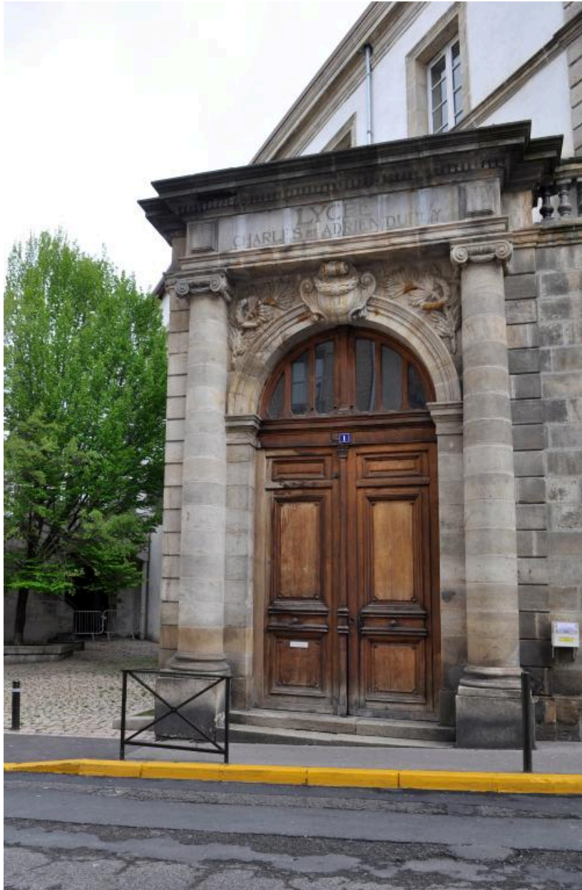
Ancienne porte d'entrée du lycée, rue du Général-Lafayette
