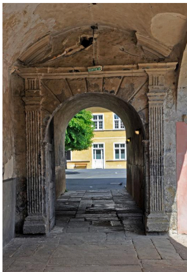
Bâtiment B : détail de la porte du passage vers la cour 2 Phot. Catherine Guégan IVR84_20194300069NUCA
