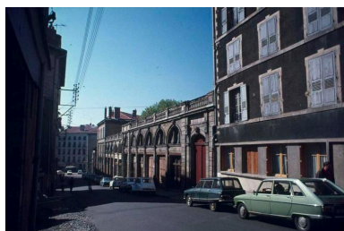
Vue de l'entrée, du préau et des boutiques depuis l'est avant 1990 Phot. Médiathèque de l'Architecture et du Patrimoine IVR84_20194300060NUCAB
