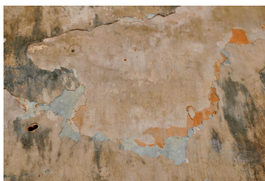
Bâtiment B : stratigraphie des badigeons sur le mur nord du portique
