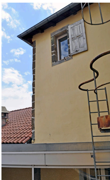
Bâtiment F, pavillon est de la cour 2 : dernier niveau de la tour d'escalier, vu de puis la cour 1 Phot. Catherine Guégan IVR84_20254300248NUCA
