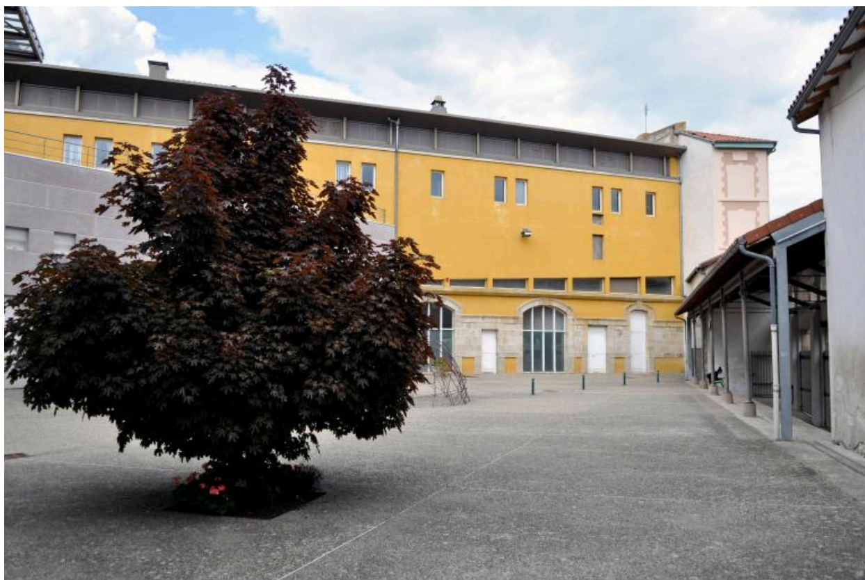
Cour 1 et bâtiment H, depuis le sud ; la façade a été fortement remaniée lors de la dernière restructuration des bâtiments, seul le rez-de-chaussée est inchangé
