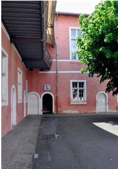
Bâtiment A : élévation sur cour 3, partie sud-ouest Phot. Catherine Guégan IVR84_20194300052NUCA
