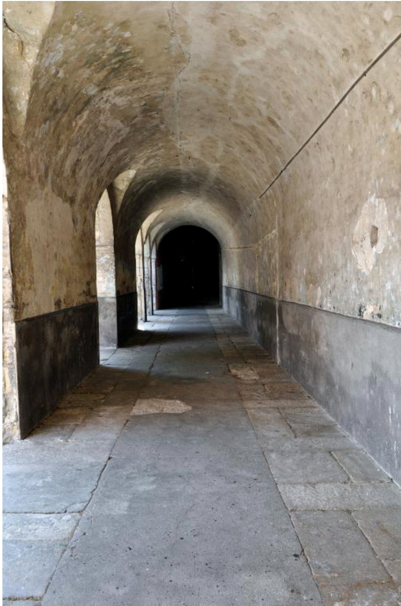
Bâtiment B : portique, depuis l'est
