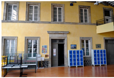
Bâtiment J : détail de l'élévation nord désormais englobée dans le nouveau hall d'accueil du collège
