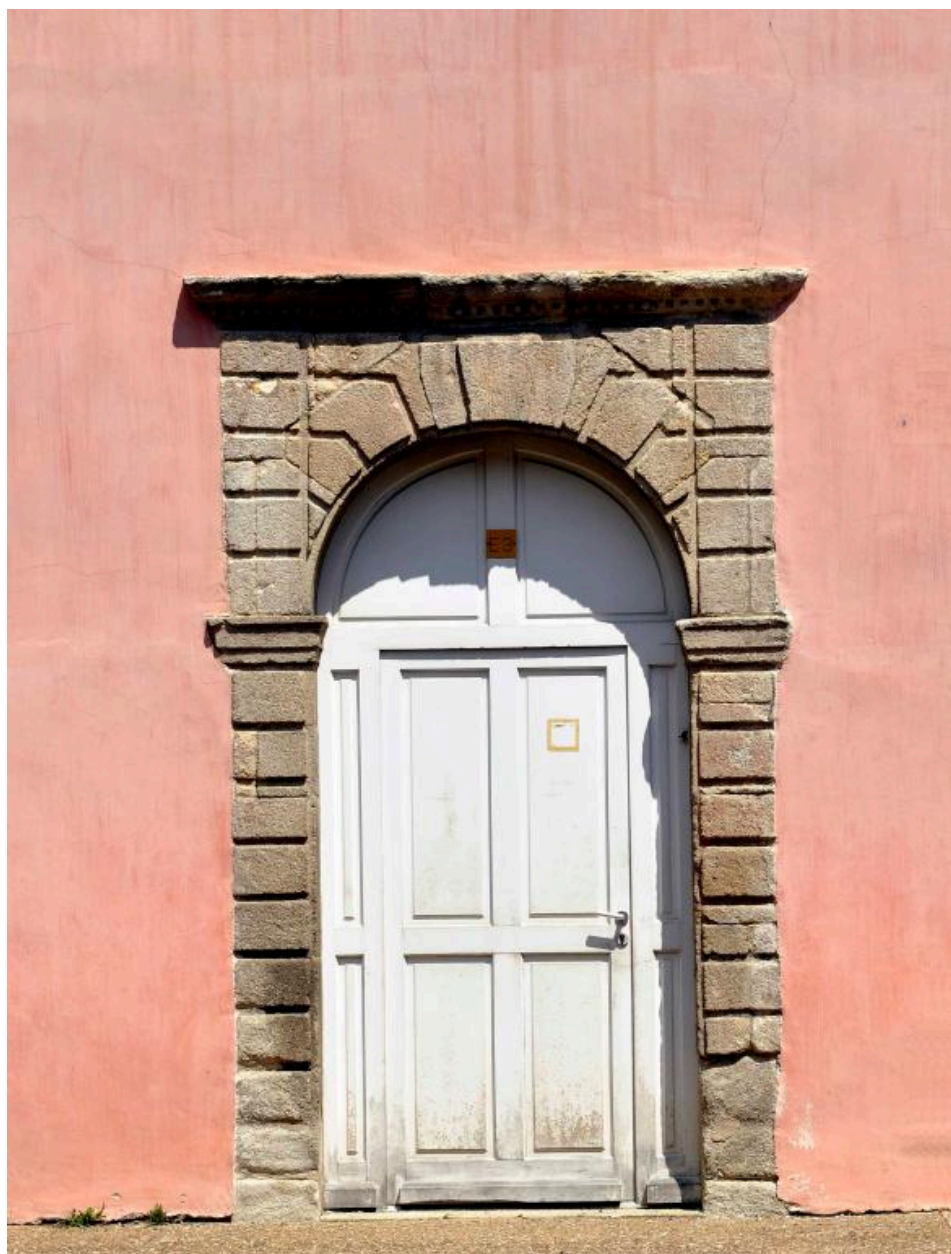
Bâtiment C : porte centrale (ancienne porte de la chapelle des Messieurs)
