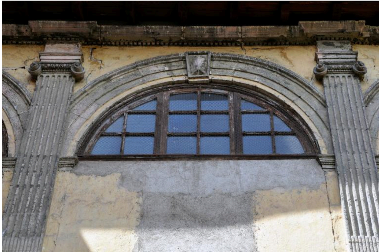
Bâtiment B : galerie, détail d'une baie
