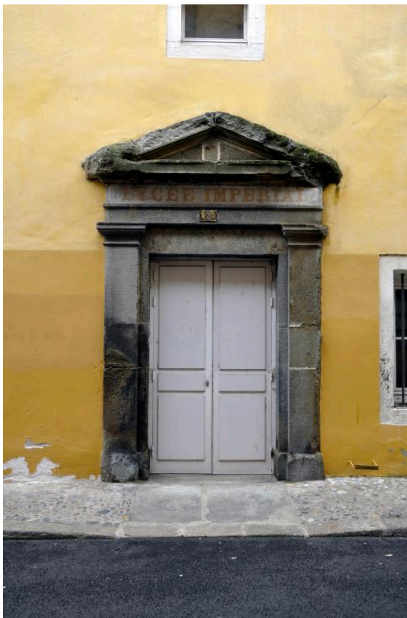
Bâtiment E : porte (17 e s.) rue Saint-François-Régis avec inscription LYCEE IMPERIAL sur l'entablement ; elle donne accès au 1 er étage du bâtiment E.
