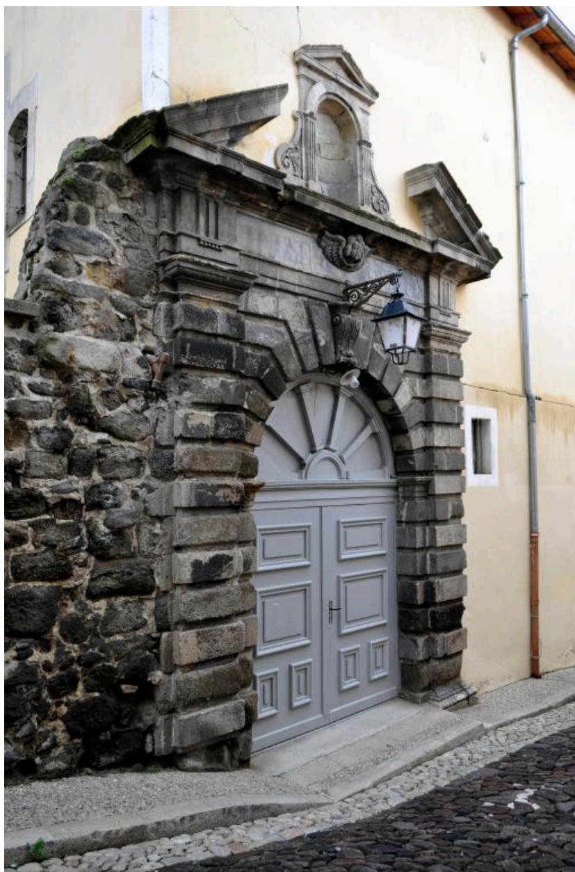
Porte principale vue de trois-quarts
