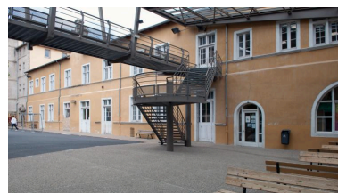
Bâtiment F : élévation sur cour 2, vue générale depuis le sud Phot. Catherine Guégan IVR84_20194300063NUCA
