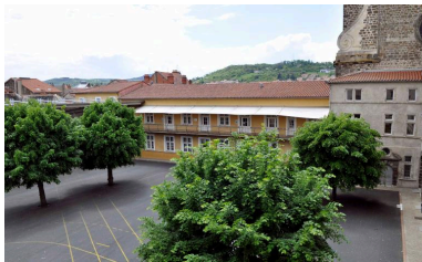
Bâtiment C : vue d'ensemble sur cour 2, depuis l'est Phot. Catherine Guégan IVR84_20194300041NUCA
