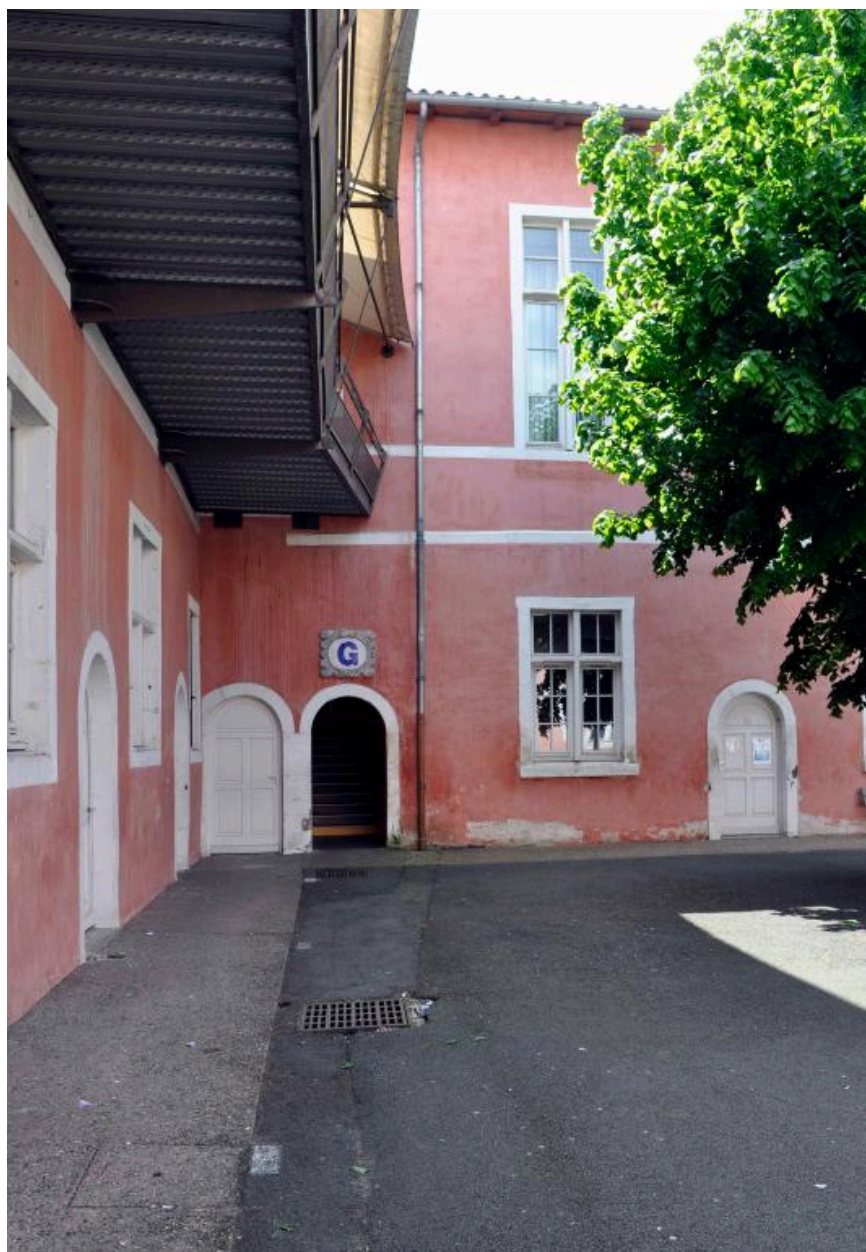
Bâtiment A : élévation sur cour 3, partie sud-ouest
