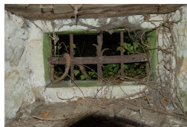
Jour avec barreaux en fer forgé. Phot. Thierry Monnet IVR84_20197400057NUCA
