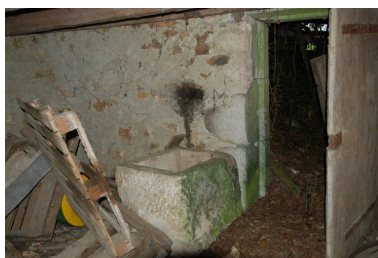
Vue intérieure de la cave avec le bloc en calcaire (saloir ?) Phot. Thierry Monnet IVR84_20197400056NUCA
