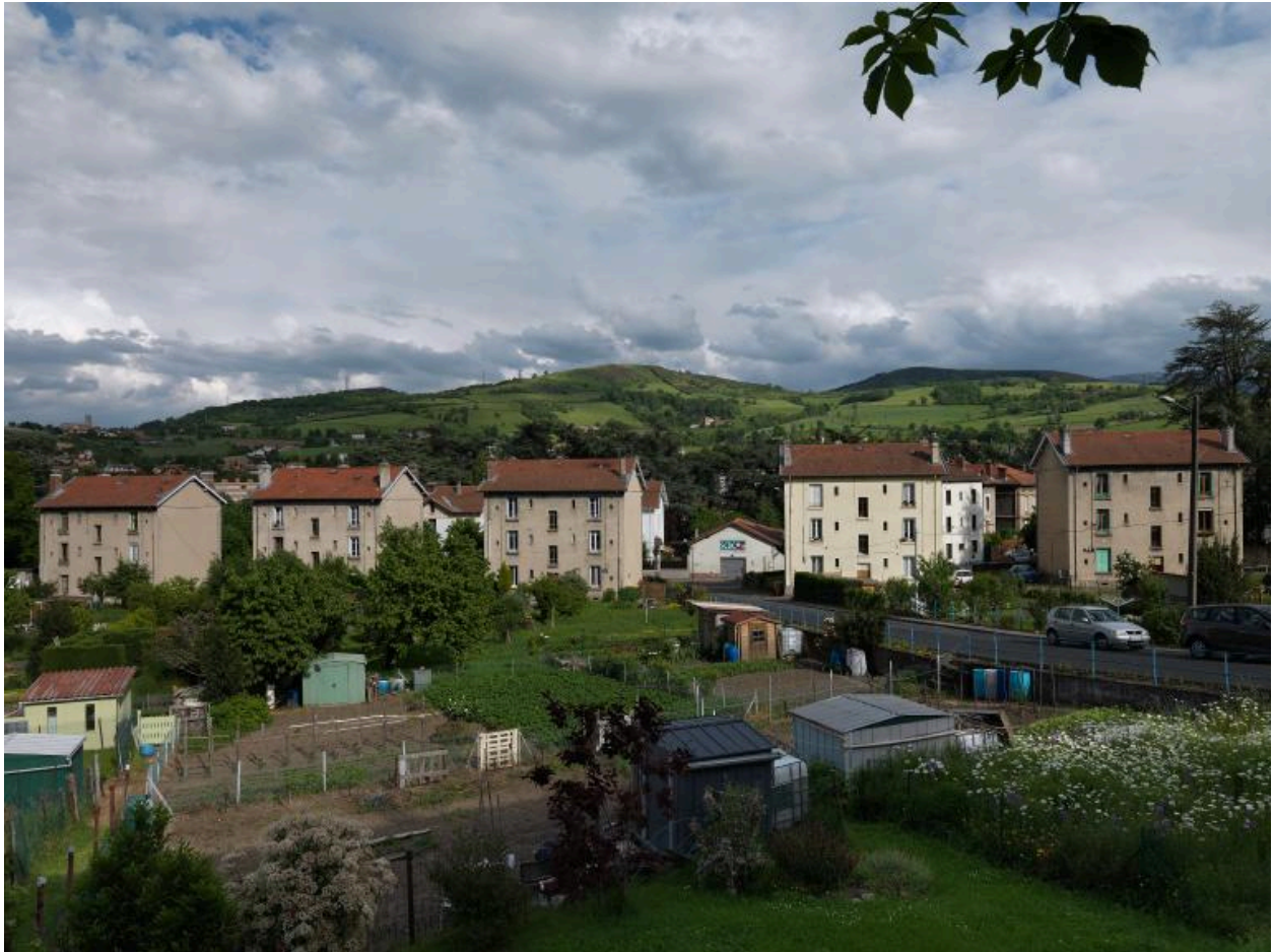
Vue d'ensemble de la cité ouvrière dite cité Gillet et des jardins ouvriers
