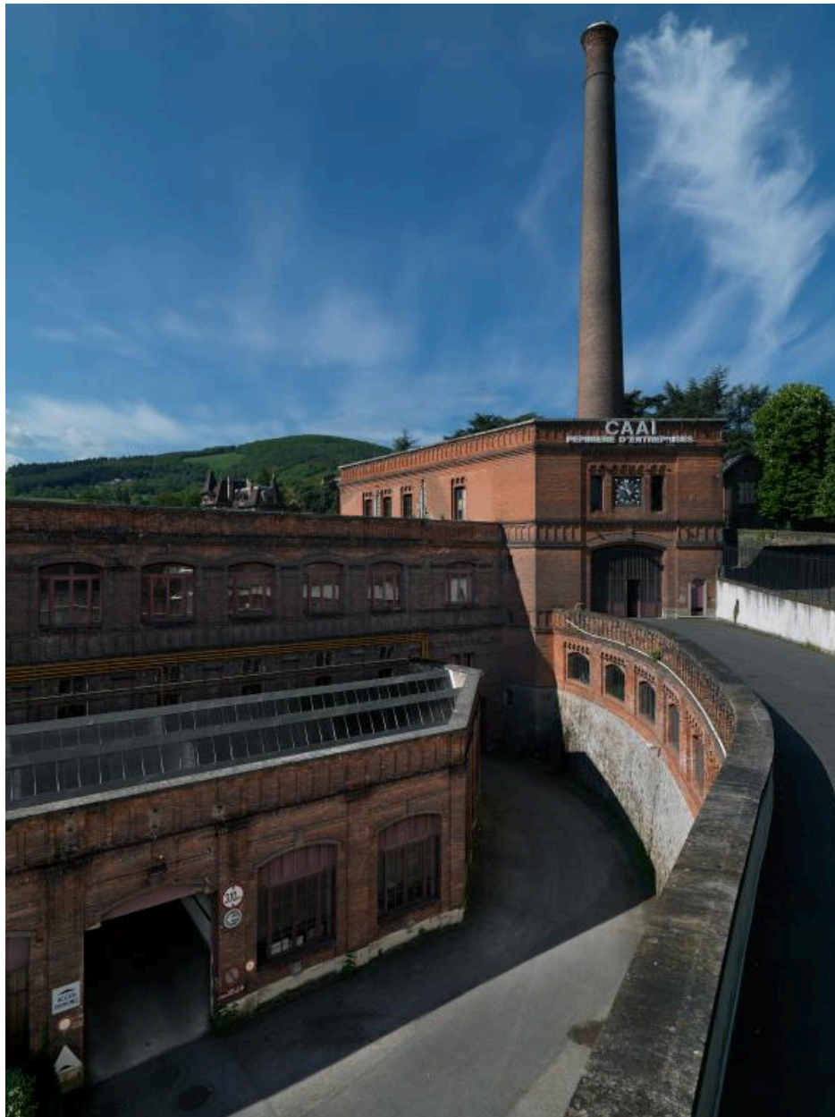
Vue d'ensemble de l'usine Gillet
