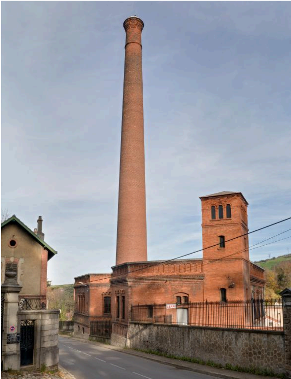
Vue d'ensemble de l'usine Gillet
