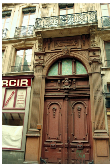
Façade principale. L'entrée
