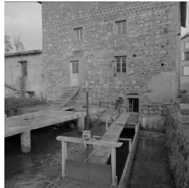
Façade latérale gauche du moulin, détail du bief et de la circulation de l'eau. Phot. Didier Gourbin IVR82_20054200127X
