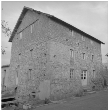
Vue d'ensemble, de trois quarts, du moulin. Phot. Didier Gourbin IVR82_20054200126X
