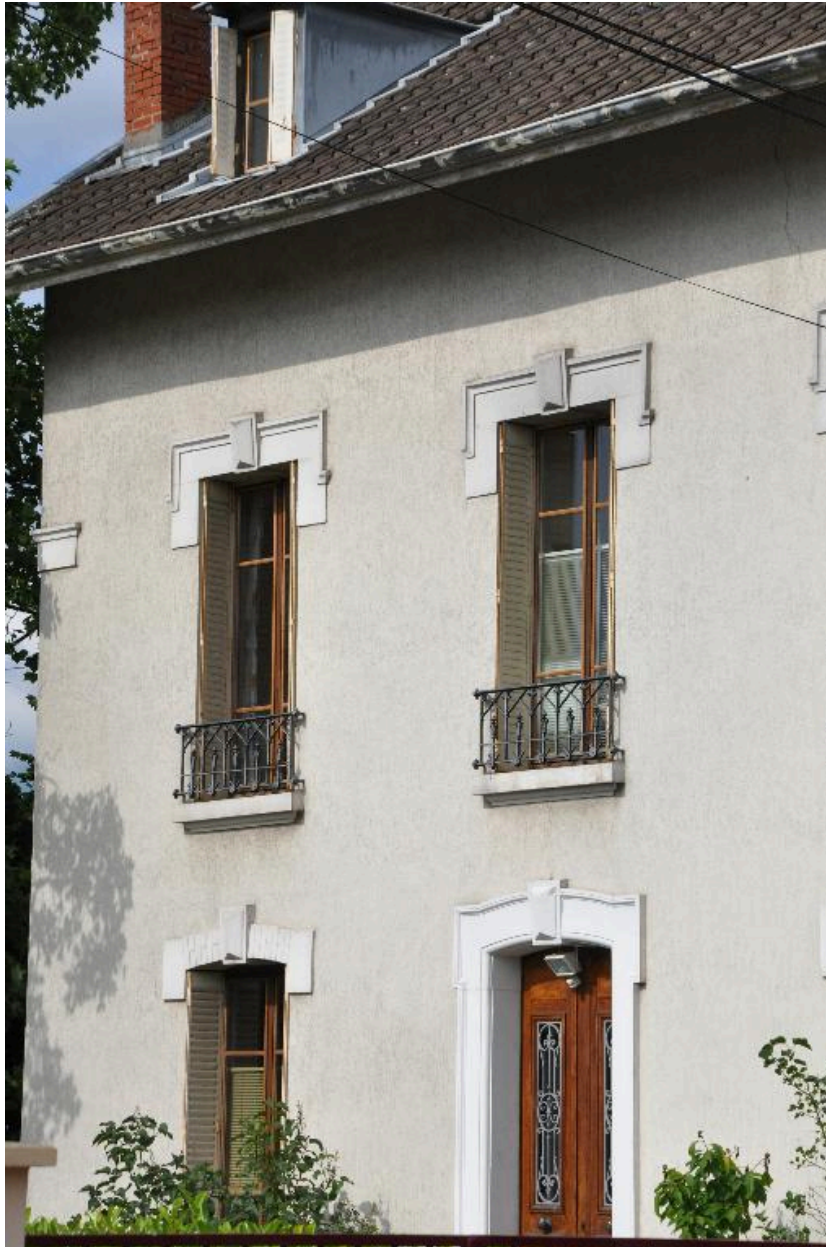
Détail des baies de l'élévation postérieure
