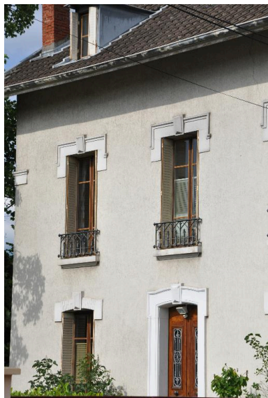
Détail des baies de l'élévation postérieure Phot. Denys Harreau IVR82_20137300573NUCA
