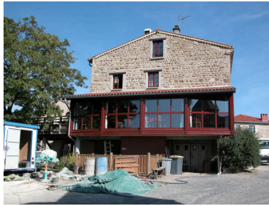
Vue d'ensemble de la façade sud. Phot. Thierry Monnet IVR82_20114201102NUCA
