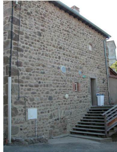
Vue d'ensemble de la façade ouest. Phot. Thierry Monnet IVR82_20114201103NUCA
