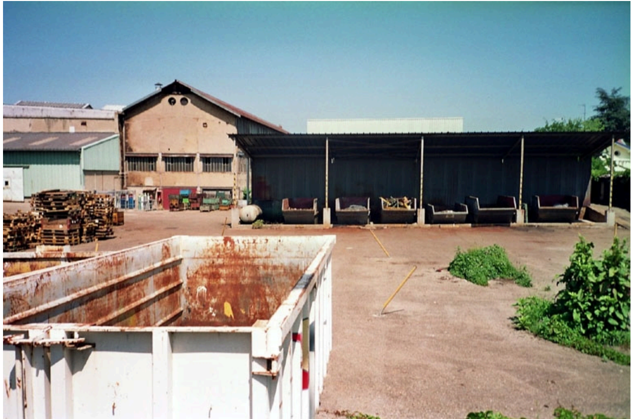
Vue d'ensemble ouest
