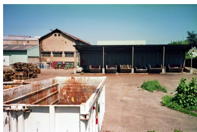
Vue d'ensemble ouest Phot. Nadine Halitim-Dubois IVR82_20066900382NUCA
