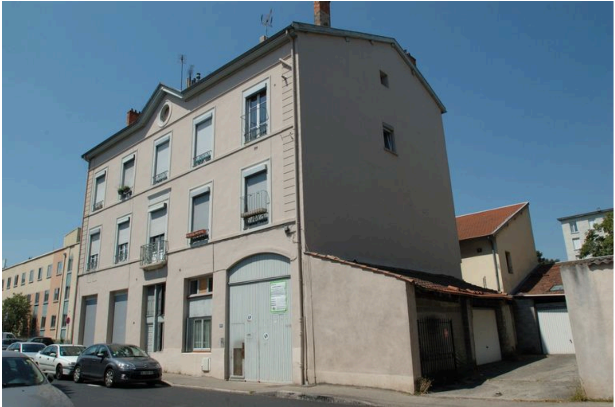
Vue de l'entrée des garages et entrepôts situés au 92 rue du Bourbonnais.
