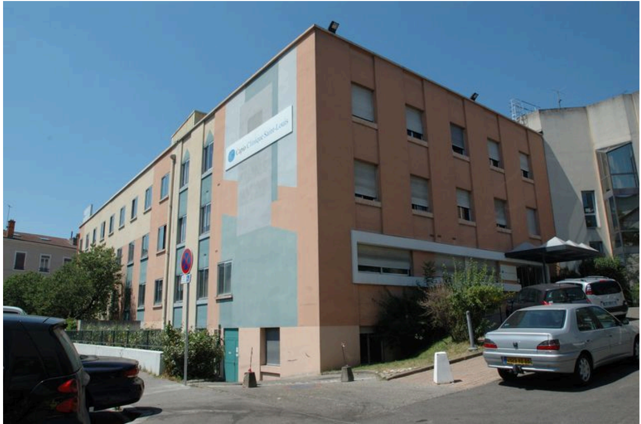
Vue des élévations sud et est.
