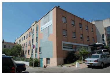
Vue des élévations sud et est.
