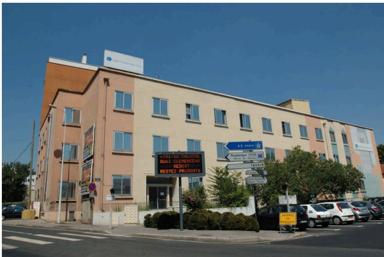
Vue générale depuis l'avenue Sidoine-Apollinaire des élévations ouest et sud.
