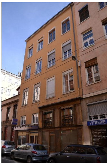
Façade ouest Phot. Noémie Caillat IVR82_20156900268NUCA
