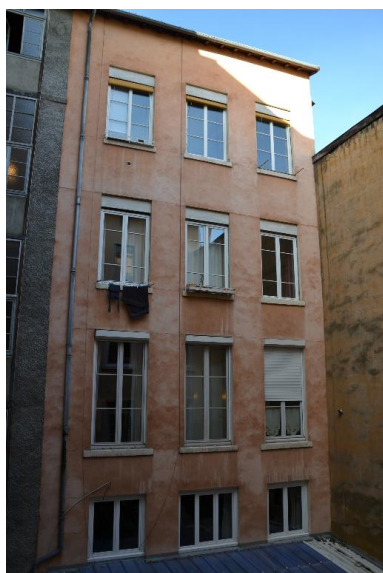
Façade est Phot. Noémie Caillat IVR82_20156900503NUCA
