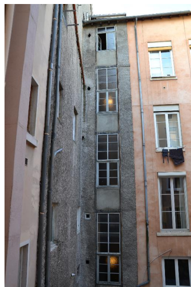
Façade est Phot. Noémie Caillat IVR82_20156900502NUCA
