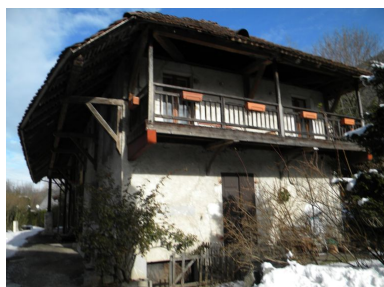
Façade principale de l'habitation en mur pignon. Phot. Jérôme Daviet
