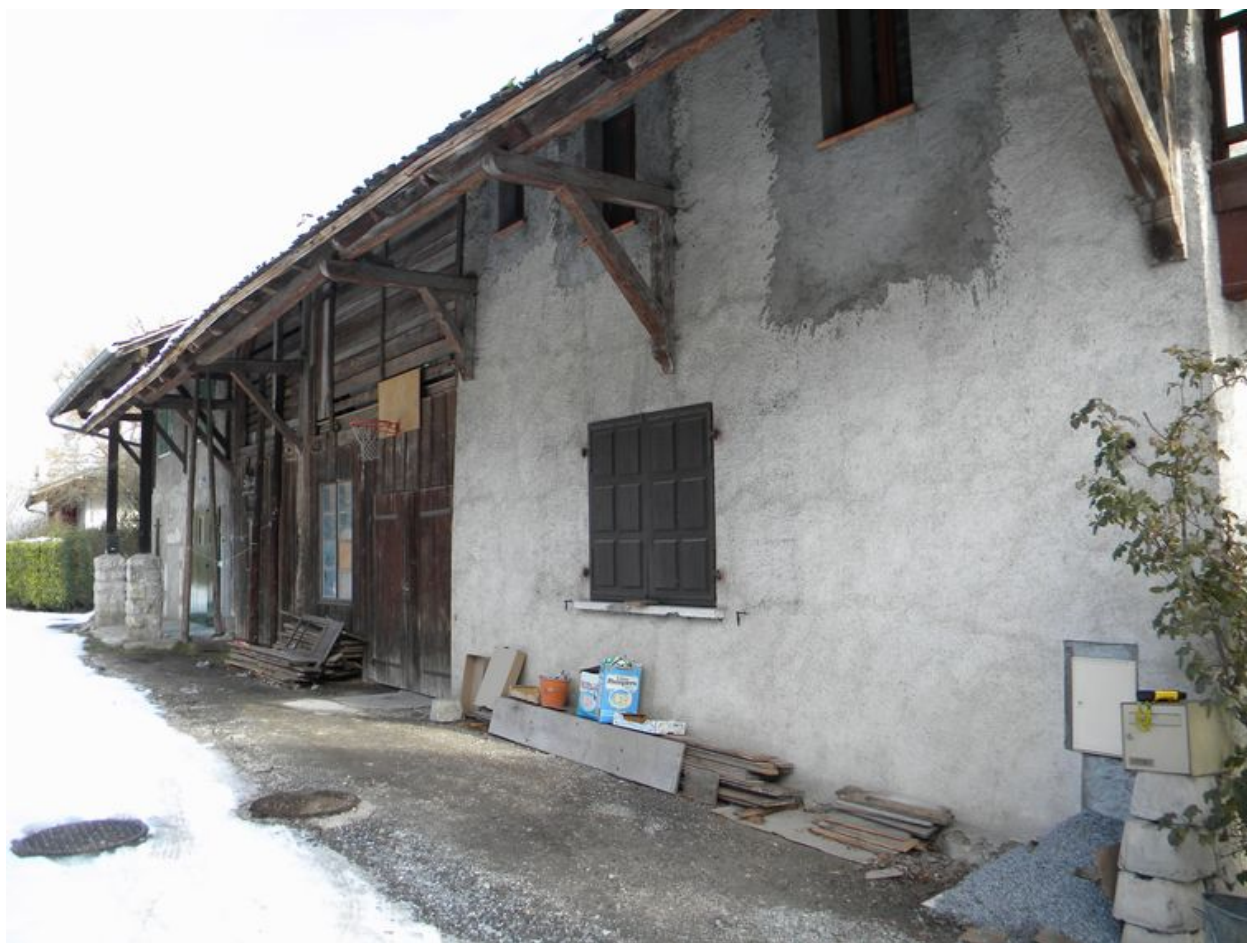
Façade principale de la scierie avec la scierie en bardage.
