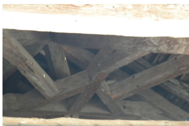
Détail de la charpente sous la croupe. Phot. Jérôme Daviet IVR82_20107400852NUCA
