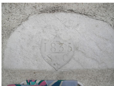
Linteau de porte avec inscription 1835 SC. Phot. Jérôme Daviet IVR82_20107400849NUCA
