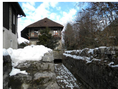
Vue générale. Phot. Jérôme Daviet IVR82_20107400846NUCA
