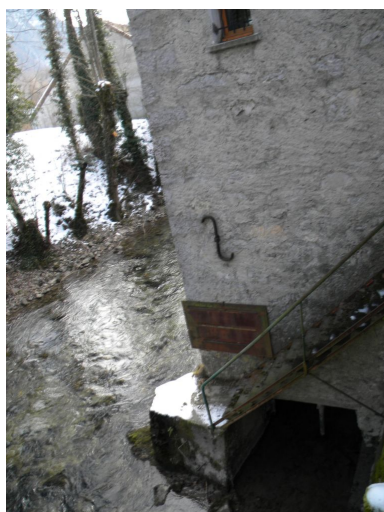
Vue de la sortie du canal sous le bâtiment. Phot. Jérôme Daviet IVR82_20107400848NUCA
