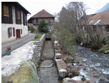
Vue générale. Phot. Jérôme Daviet IVR82_20107400847NUCA
