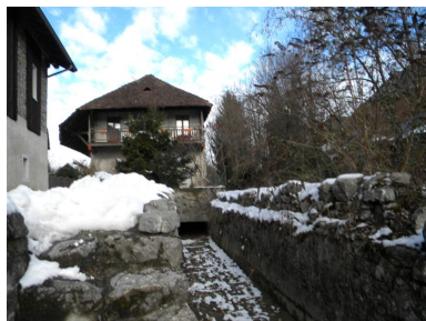
Vue générale depuis le pont avec le canal d'amenée d'eau.
