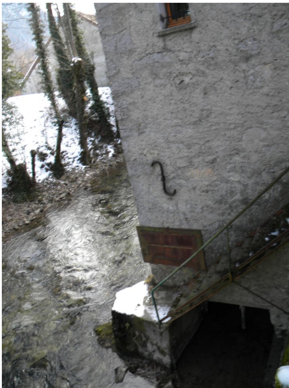
Vue de la sortie du canal sous le bâtiment.
