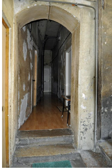
Vue du couloir desservant les étages de l'immeuble depuis l'escalier du 15 rue Reinach Phot. Catherine Guégan IVR82_20156902520NUCA
