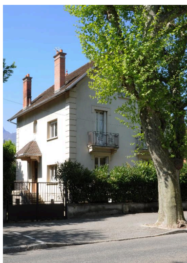
Vue d'ensemble depuis la rue Phot. Denys Harreau IVR82_20147300586NUCA
